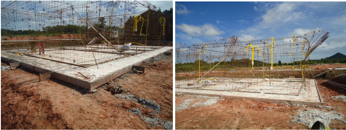
Figura 18 – Armadura posicionada sobre o radier.
