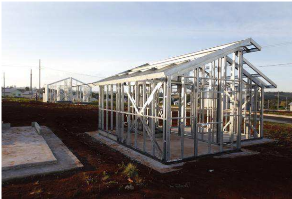
Figura 9 – Sistema steel frame . Fonte: CAMPOS e SOUZA, 2010.
