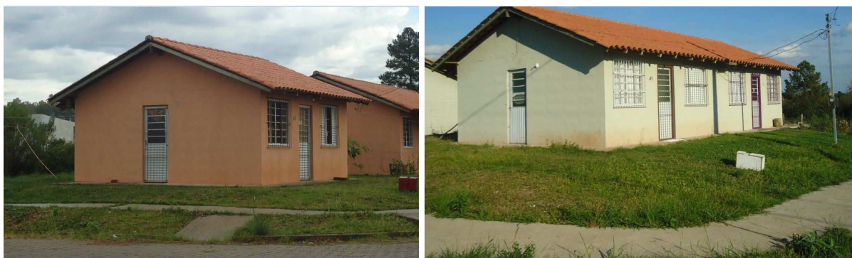
Figura 66 – Casas destinadas aos cadeirantes, sem pavimentação nos acessos.
