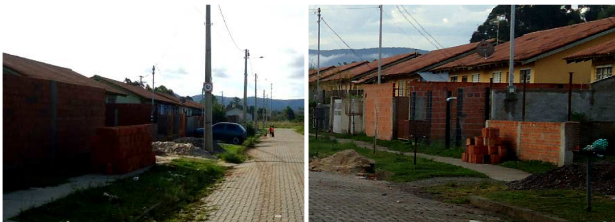
Figura 33 – Depósito de materiais de construção obstruindo a via.
