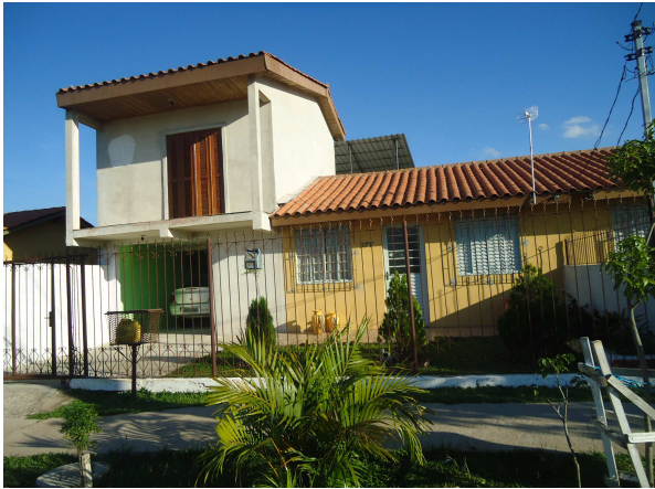
Figura 57 – Ampliação para dois pavimentos.
