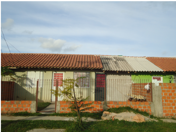
Figura 59 – Ampliação lateral térrea.
