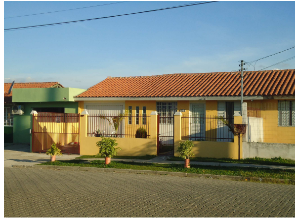
Figura 58 – Ampliação lateral térrea.
