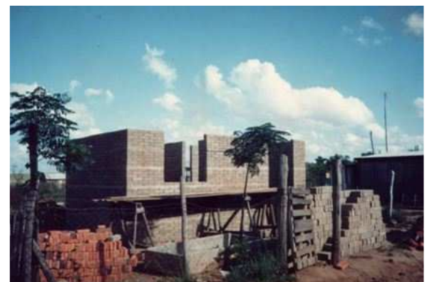
Figura 12 – Habitação em Solo-cimento. Fonte: SOARES, 2007.
