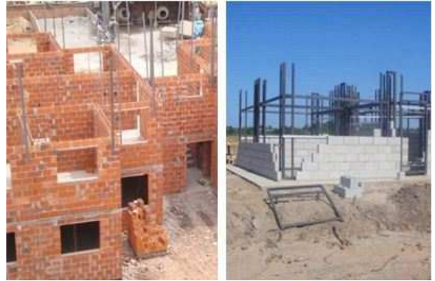
Figura 8 – Alvenaria estrutural. Fonte: PINHO, 2010.
