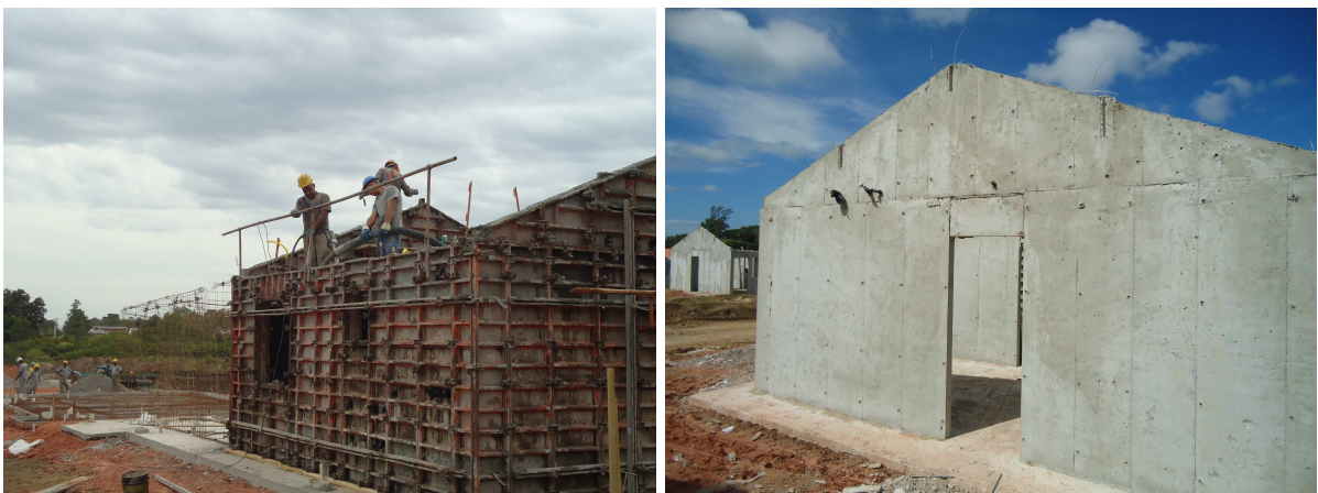
Figura 20 – Lançamento do concreto nas fôrmas e as paredes já desenformadas.
