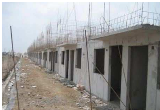
Figura 16 – Paredes de concreto. Fonte: PINA, 2013.
