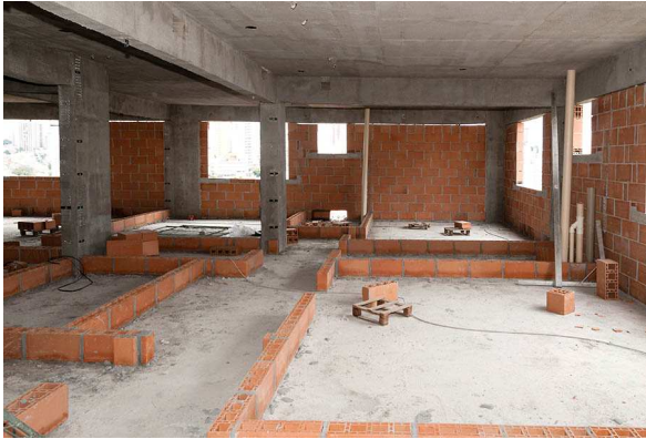
Figura 7 – Alvenaria de vedação. Fonte: Arquivo pessoal, 2015.
