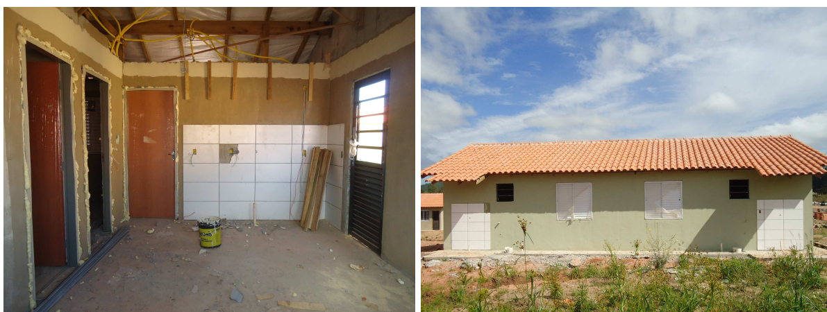
Figura 21 – Edificação em sua fase de acabamentos.
