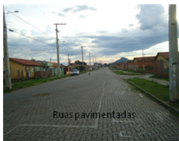
Figura 32 – Pavimentação das vias.
