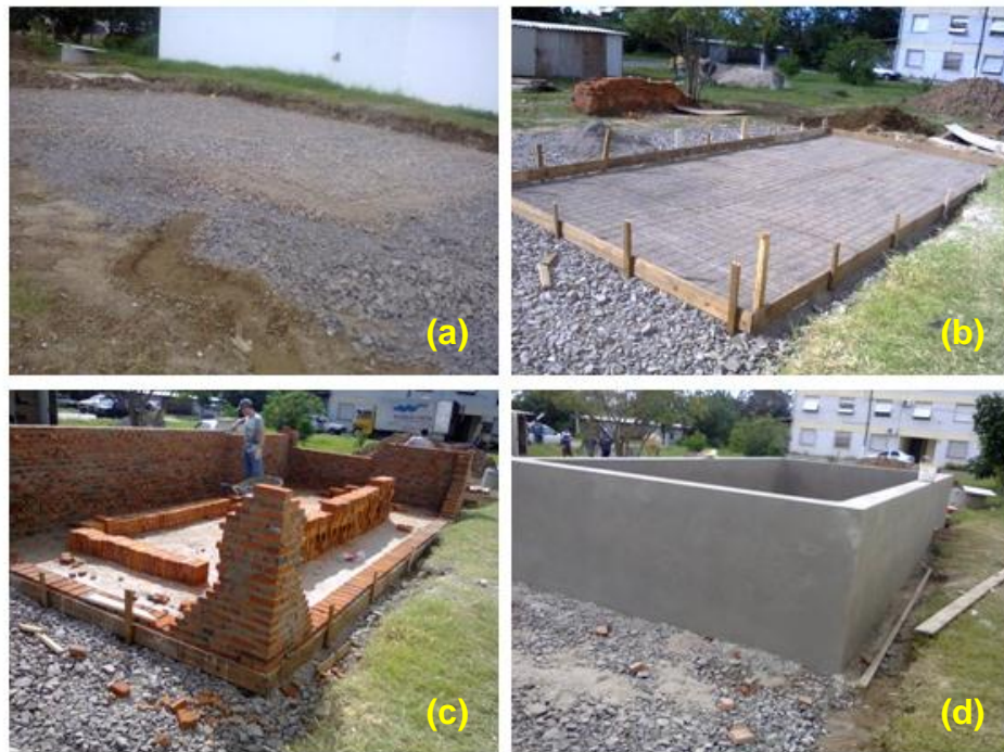
Figura 11 - Etapas da instalação do WCFV. a) e b) fundações; c) alvenaria; d) revestimento
