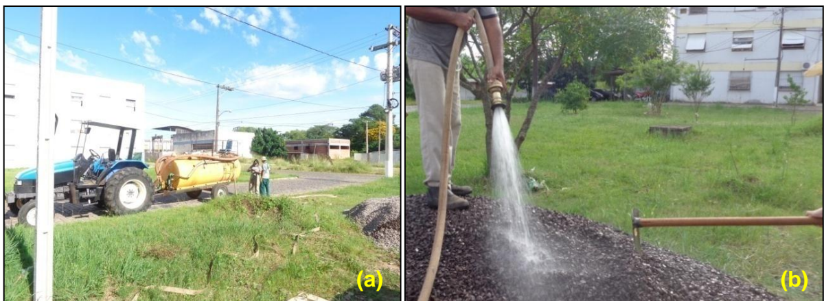
Figura 14 - Lavagem da brita. A fotografia (a) mostra o trator com carreta Pipa utilizado.
