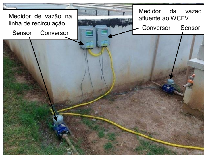
Figura 19 - Medidores eletromagnéticos. À direita, o medidor da vazão afluyente ao WCFV. À esquerda, o medidor de vazão na linha de recirculação.
