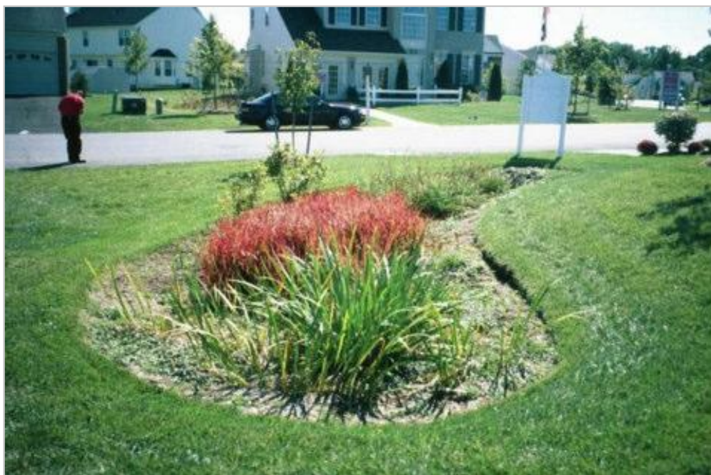
Figura 10 - Aplicação de uma biorretenção.
