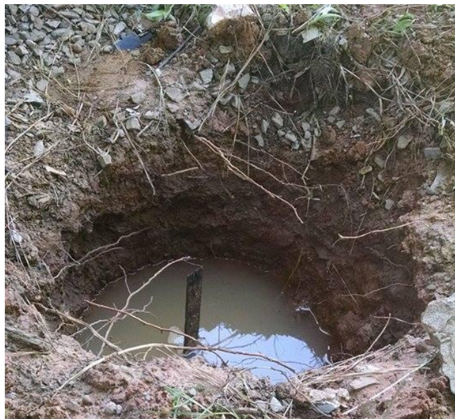
Figura 25 - Cava 01 com nível de água em 0,15m.
