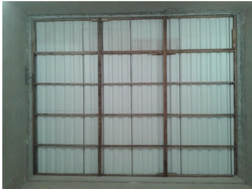
Figura 43 – Vista da montagem da estrutura para sustentação das telhas.
