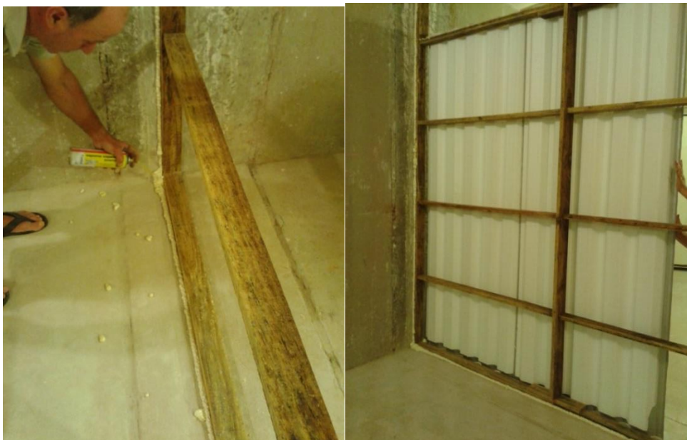
Figura 44 – Aplicação de poliuretano expandido no perímetro da estrutura de sustentação.
