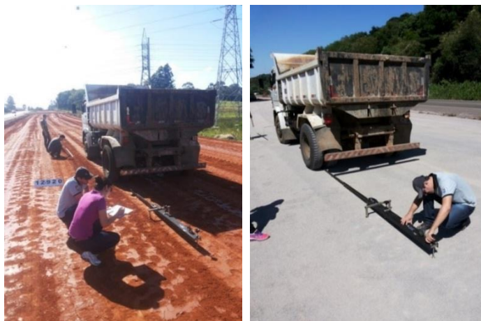
Figura 2.11 – Realização de ensaios com a viga Benkelman em camadas subjacentes ao revestimento
