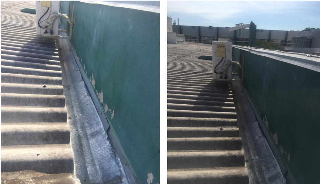
Figura 102 – Detalhe da calha, rufos e algerozas
