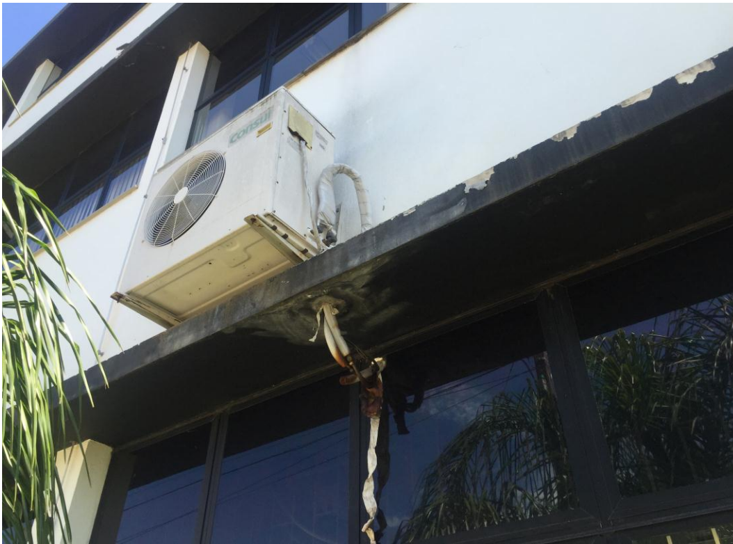
Figura 111 – Manchas de mofo na fachada indicando o mau funcionamento das pingadeiras sob as esquadrias
