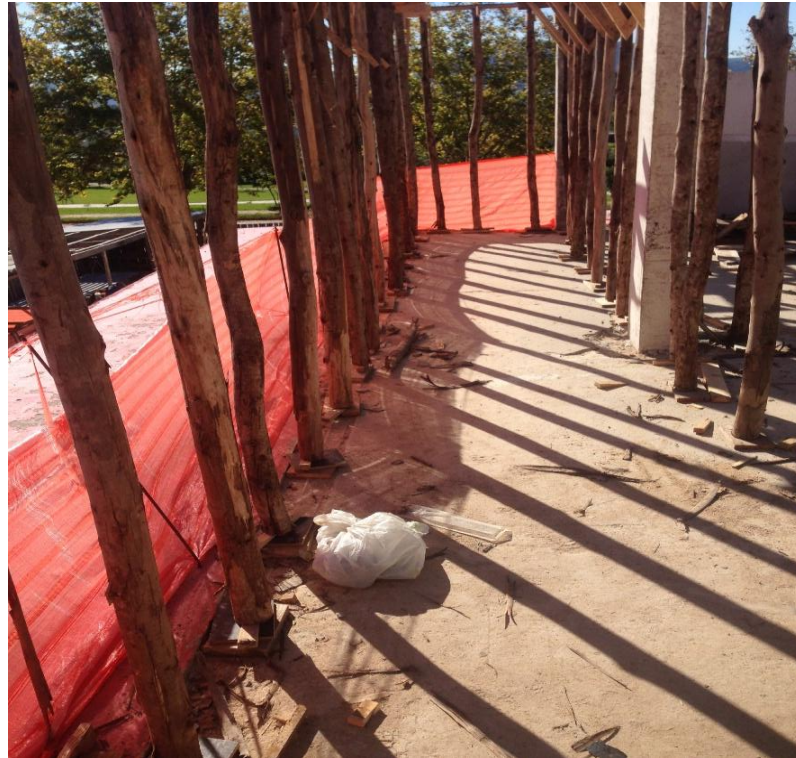
Figura 27 – Fissuras na laje do segundo pavimento
