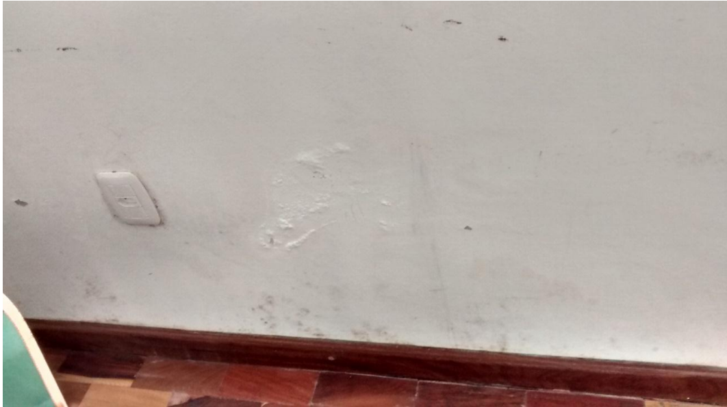
Figura 80 – Mofo em revestimento interno de parede junto à dreno externo de ar condicionado
