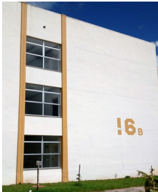
Figura 70 – Fachada leste do Prédio do Anexo B do Centro de Educação
