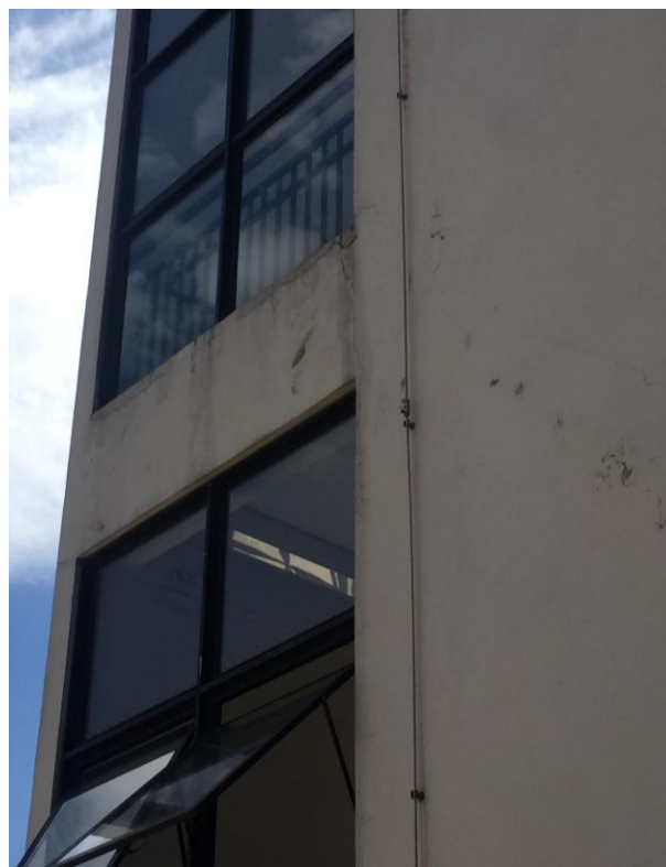
Figura 111 – Manchas de mofo na fachada indicando o mau funcionamento das pingadeiras sob as esquadrias
