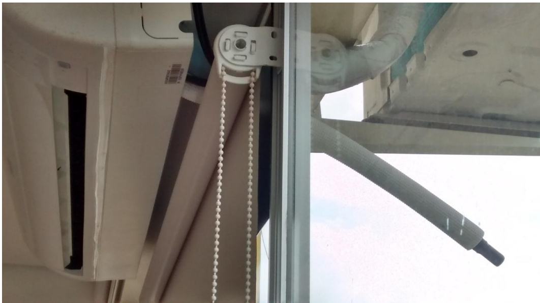
Figura 76 – Detalhe da instalação de equipamento de ar condicionado
