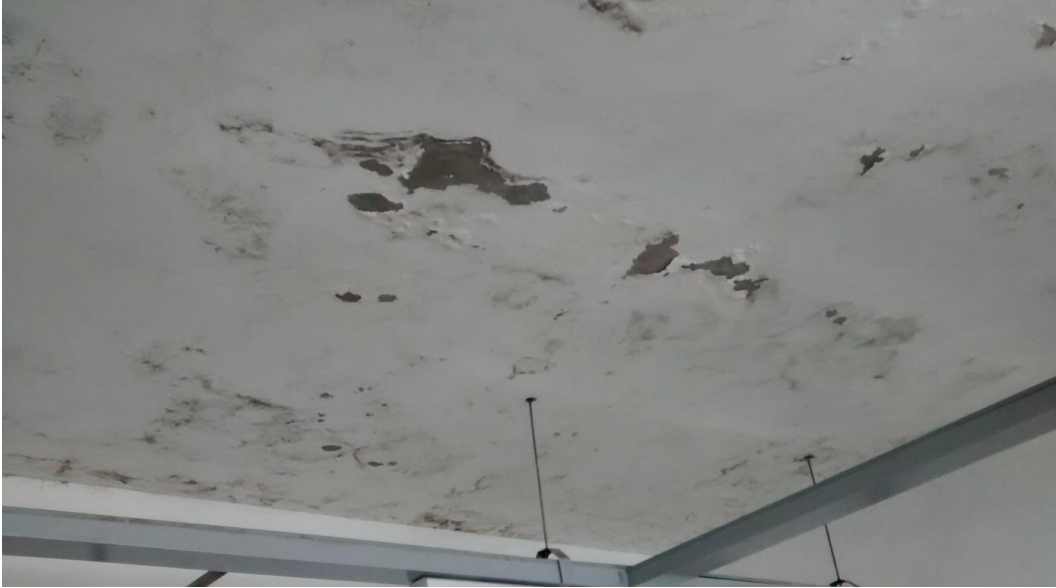
Figura 56 – Detalhe do teto da recepção no segundo pavimento
