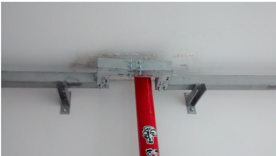
Figura 84 – Bolhas na pintura junto à tubulação de combate à incêndio
