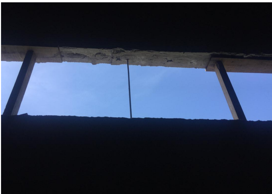
Figura 93 – Vão de esquadria executado sem verga de concreto
