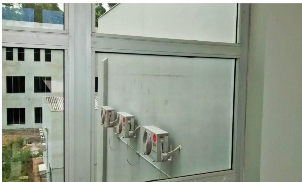
Figura 40 – Fissuras e trinca horizontal na parede do estúdio de música
