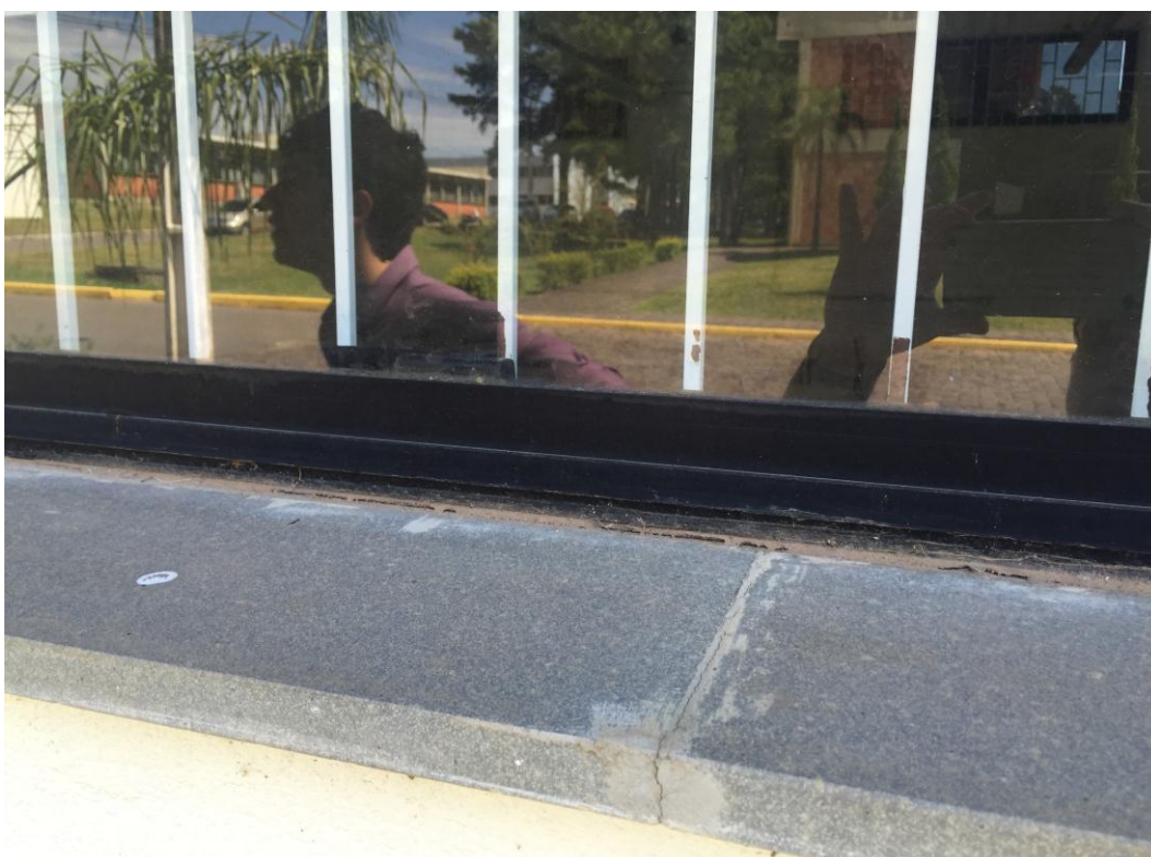
Figura 113 – Fissura no remate do peitoril da esquadria
