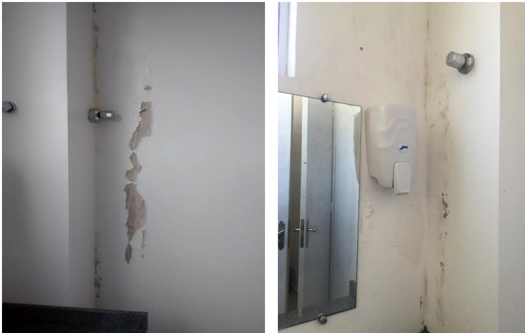
Figura 84 – Bolhas na pintura junto à tubulação de combate à incêndio
