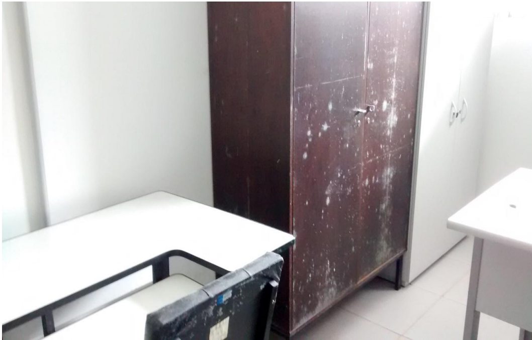
Figura 67 – Mofo na mobília por presença de umidade
