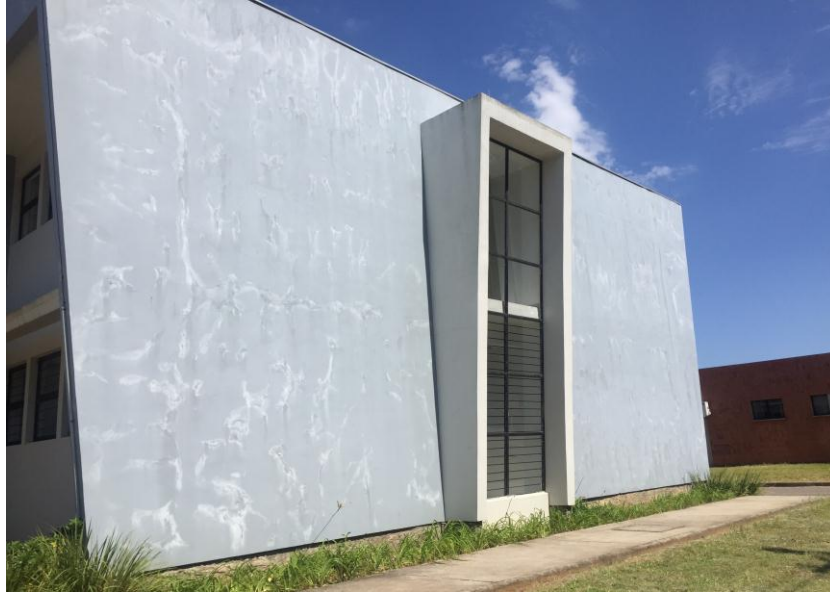
Figura 54 – Fachada frontal (leste)
