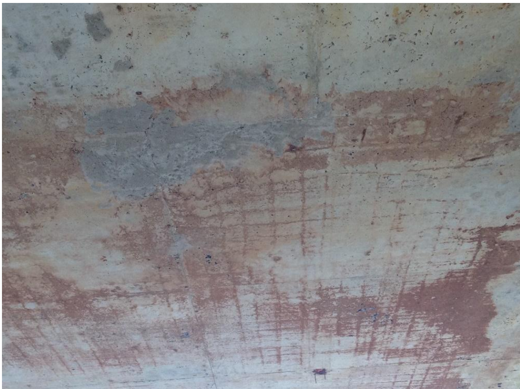
Figura 36 – Laje com mapeamento de armadura
