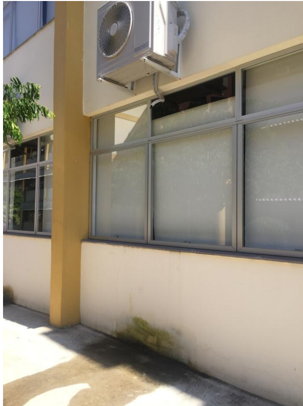
Figura 77 – Detalhe da instalação de equipamento de ar condicionado
