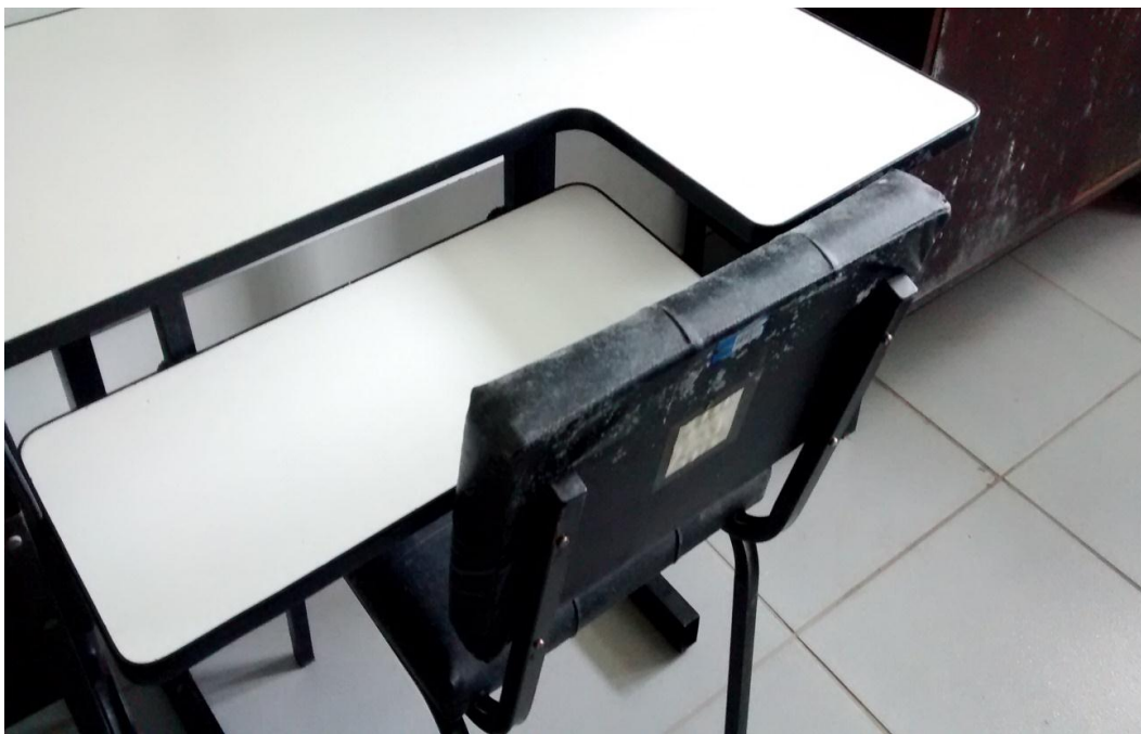
Figura 68 – Mofo na mobília por presença de umidade
