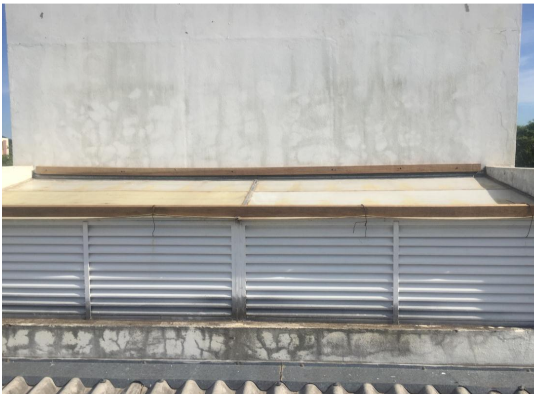
Figura 105 – Detalhe da instalação da cobertura de policarbonato cujas ranhuras estão no sentido oposto ao caimento da água da chuva e elementos de fixação sobressalentes
