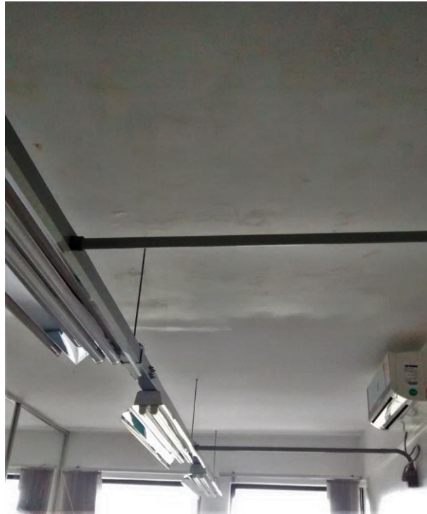
Figura 63 – Mofo e manchas de umidade em parede do laboratório
