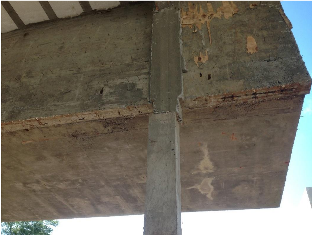
Figura 32 – Vista do pilar de apoio com seção 20 cm x 20 cm
