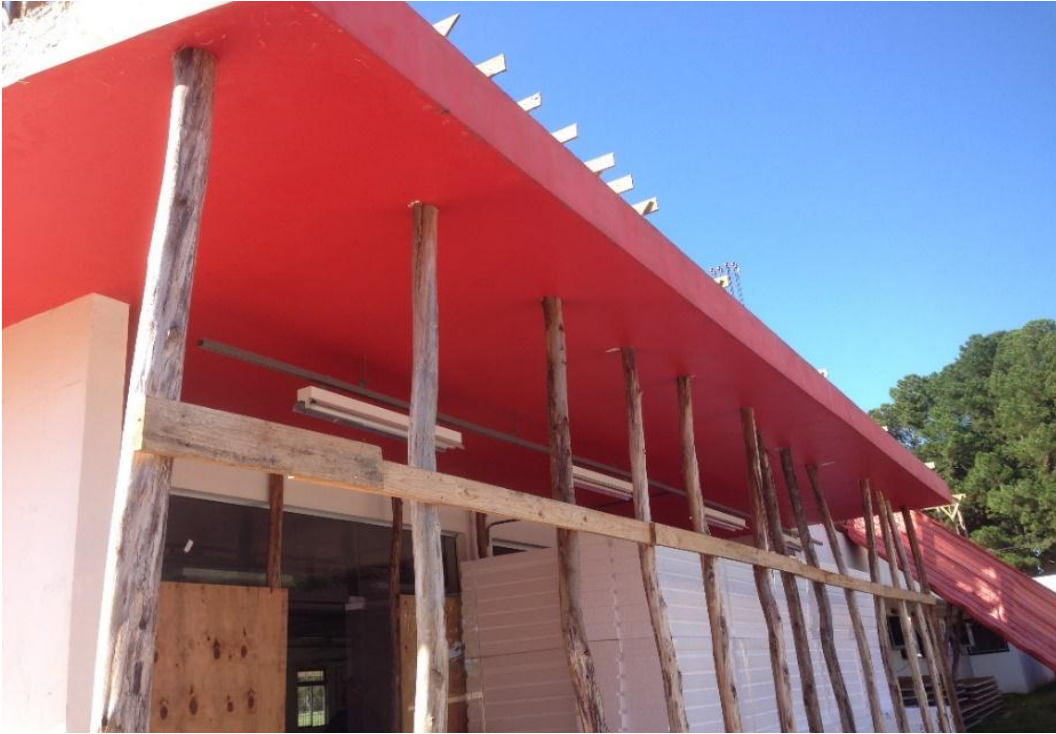
Figura 25 – Vista inferior da marquise
