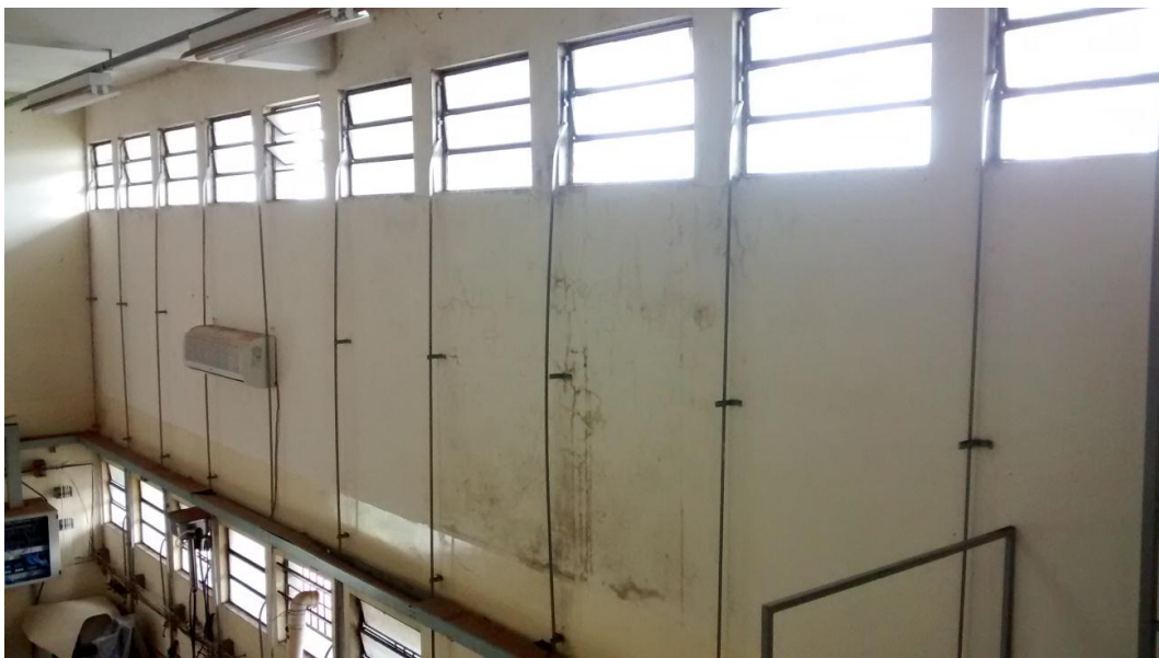
Figura 63 – Mofo e manchas de umidade em parede do laboratório
