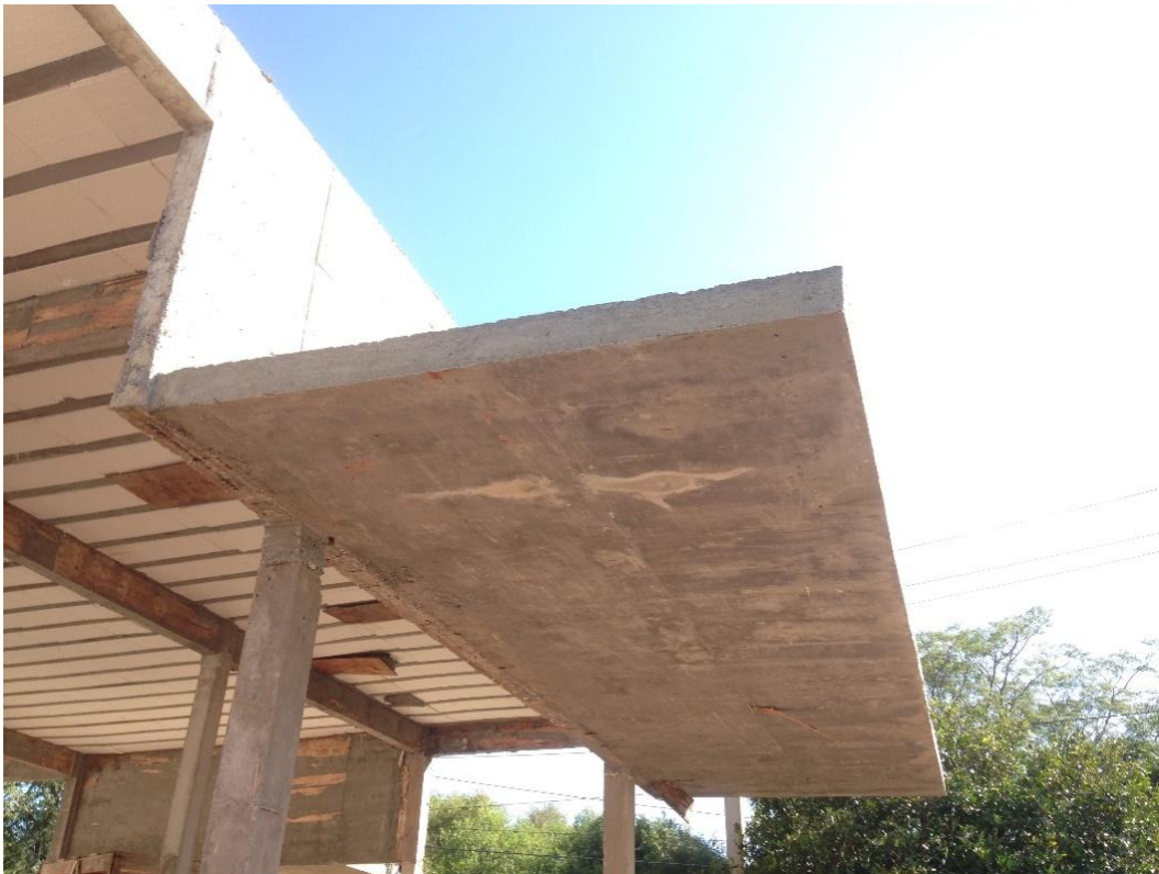
Figura 31 – Vista inferior da marquise
