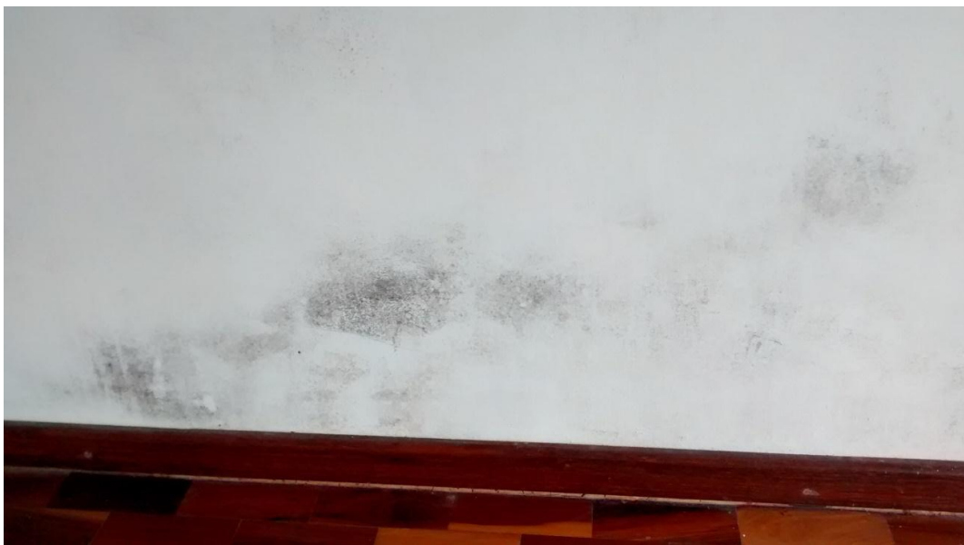
Figura 80 – Mofo em revestimento interno de parede junto à dreno externo de ar condicionado
