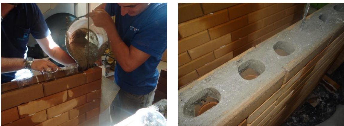
Figura 28 – a) Execução do graute a 0,98 m de parede b) graute pronto
