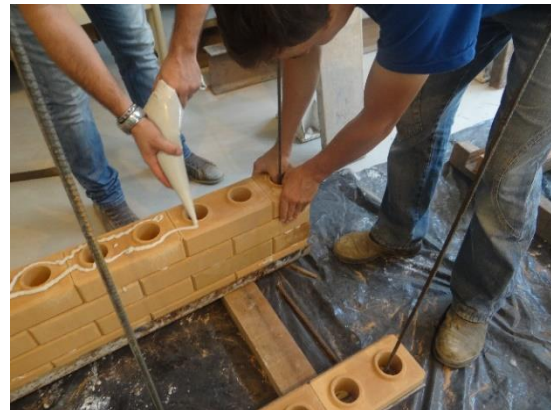
Figura 26 – a) Ferros soldados em uma base metálica de perfil C b) início do assentamento dos blocos
