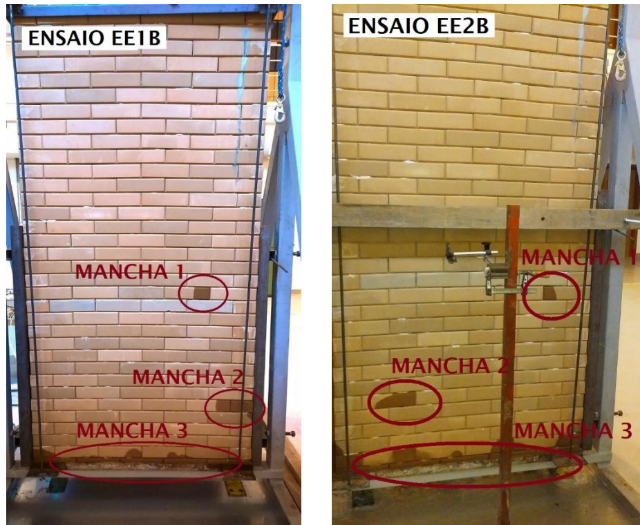
Figura 38 – a) Parede B - Análise visual da face interna após o primeiro (EE1B) e b) segundo (EE2B) ensaio de estanqueidade à água da chuva
