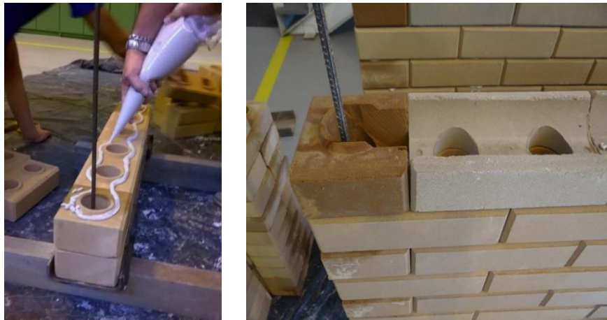
Figura 27 – a) Aplicação da massa para assentamento b) última fiada com tijolos do tipo canaleta
