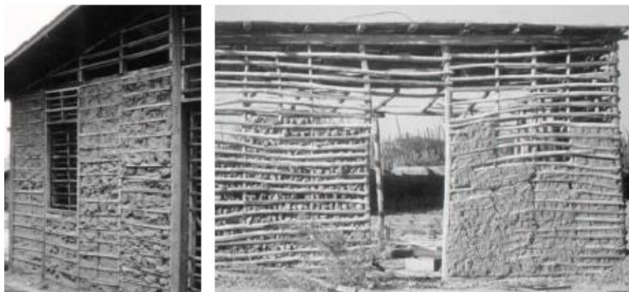
Figura 15 – Paredes de tabique
