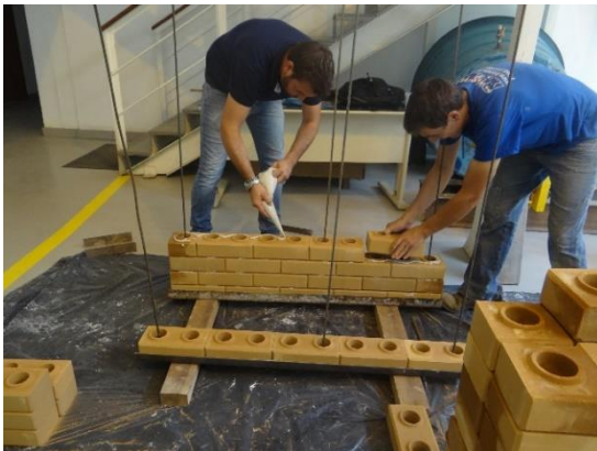
Figura 26 – a) Ferros soldados em uma base metálica de perfil C b) início do assentamento dos blocos
