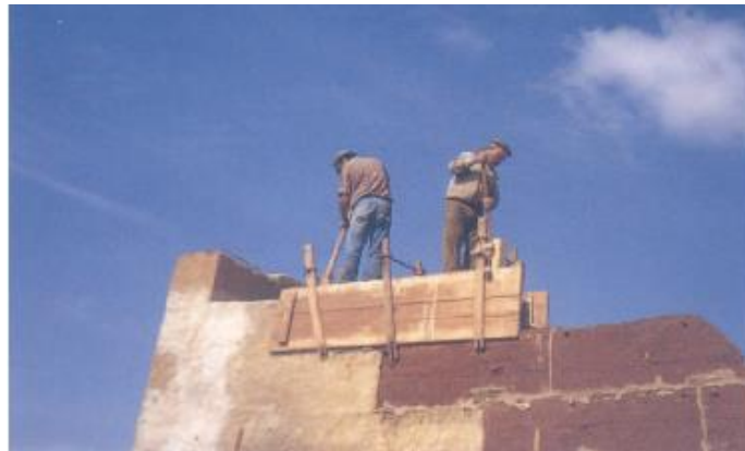
Figura 16 – Execução de parede em taipa de pilão
