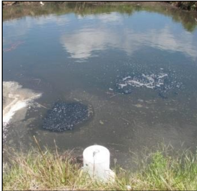
Figura 33 – Fluxo ebulitivo gerado a partir da lagoa anaeróbia
