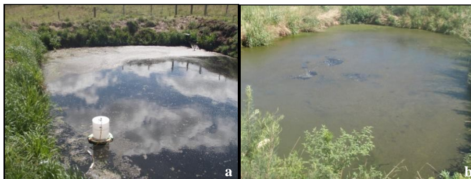
Figura 28 – Lagoa anaeróbia a) com camada parcial de espuma b) com espuma diluída
