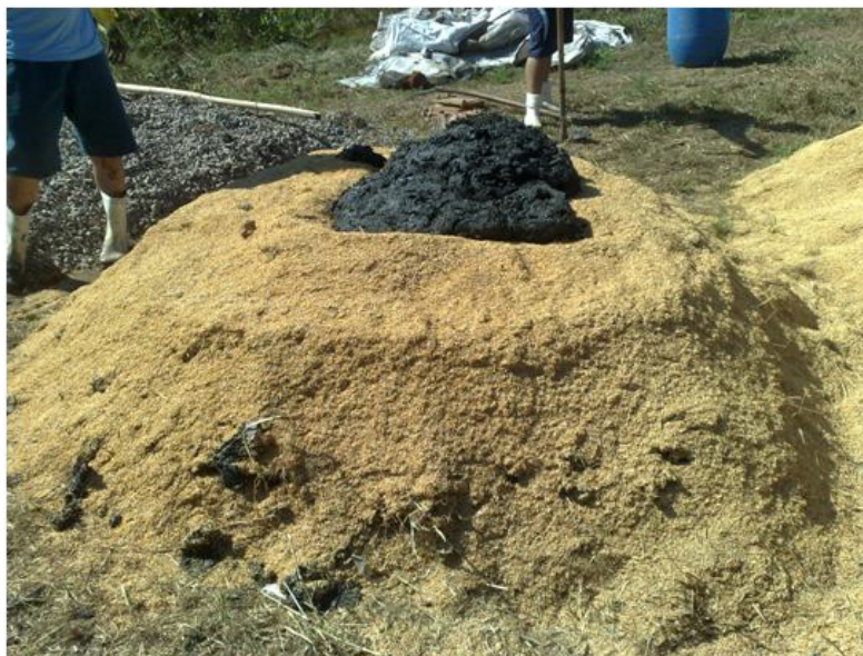
Figura 31 - Construção da leira de casca de arroz e lodo desaguado.
