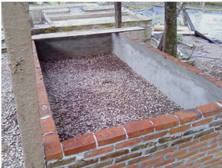
Figura 16 - Leito de secagem em construção.
