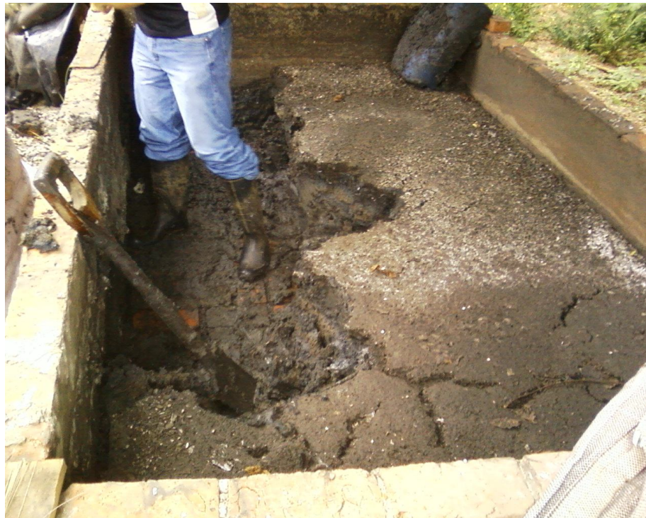
Figura 30 - Retirada do lodo desaguado.
