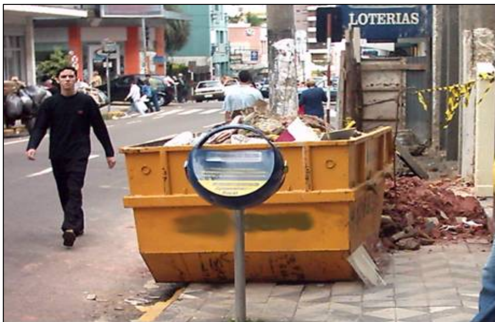
FIGURA 32 – Caçamba impedindo o trânsito de pedestres na calçada (2005)
