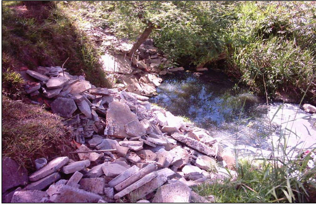
FIGURA 22 – Uso inadequado de cascalho para conter margens de arroio (UFSM 15 -2004)
