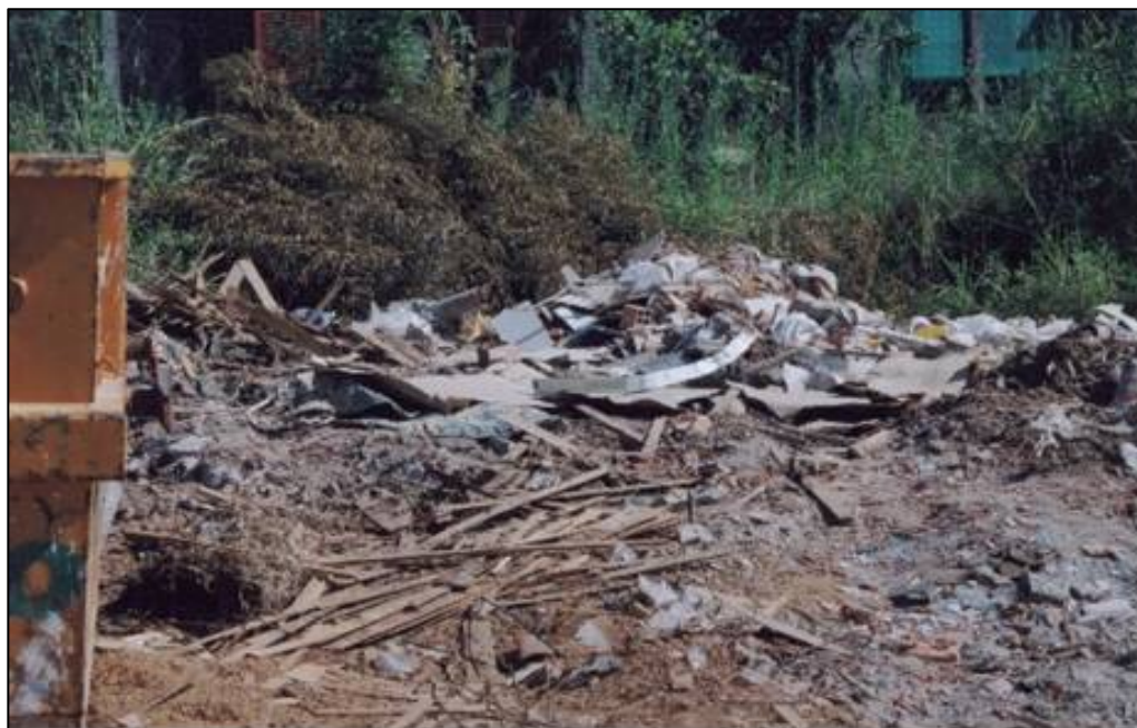
FIGURA 44 – Entulhos sem triagem nem cuidados na disposição – Presídio/SM (2004)
