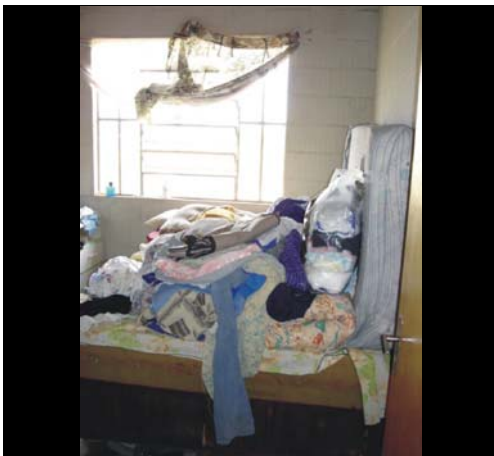
FIGURA 18: Vista C3.1. Cama em péssimo estado utilizada como depósito de roupas.
