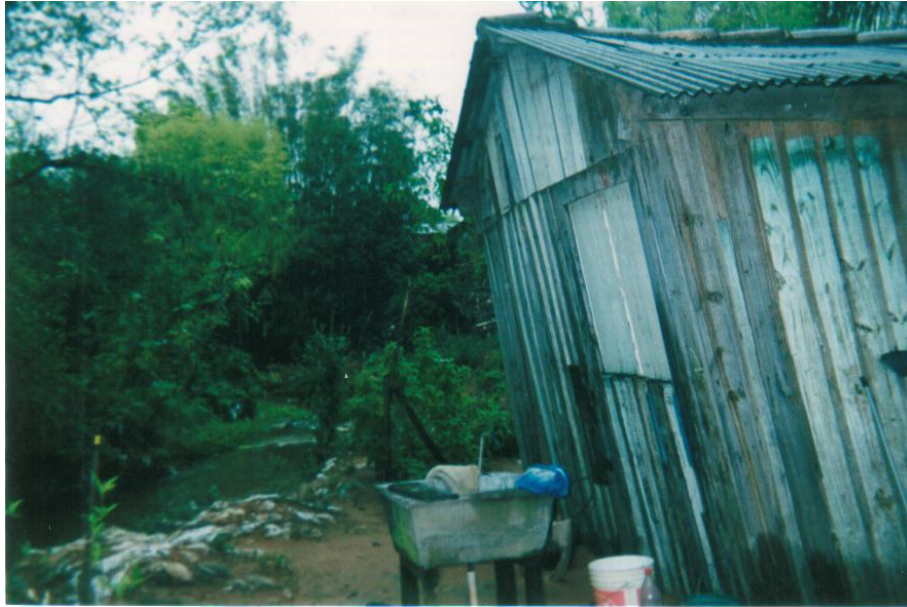
FIGURA 02: Habitação em área de risco, às margens do Arroio Cadena Fonte: arquivo pessoal Zulmira Kist
