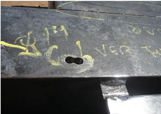
**Figura 13** – Furo não conforme com projeto.
