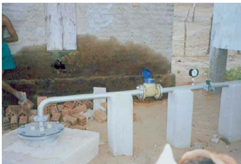
Figura. 9 – Boca do poço de um sistema do Projeto Eldorado em Inajá, PE. (Foto: Fedrizzi, 1998).
