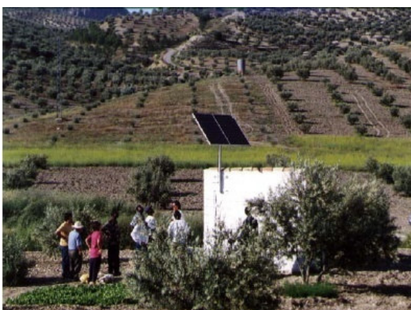
Figuras 11 e 12 – Sistemas de bombeamento fotovoltaico utilizados para irrigação de oliveirais, instalados nas proximidades de uma rede de transmissão de energia elétrica em Jaén, Espanha.
