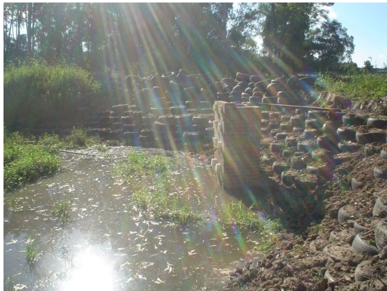
Figura 21: Barragem com enrocamento de pneus, em funcionamento na estação 1, na UFSM – Santa Maria - RS.). ( Fonte: Foto do autor).
