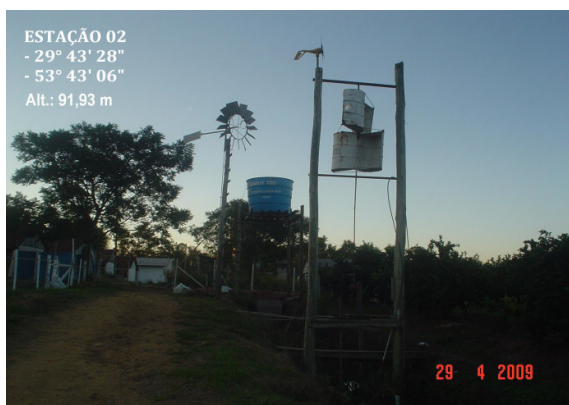
Figura 29 - Estação de bombeamento 2 ( UFSM ). (Fonte: Foto do autor).
