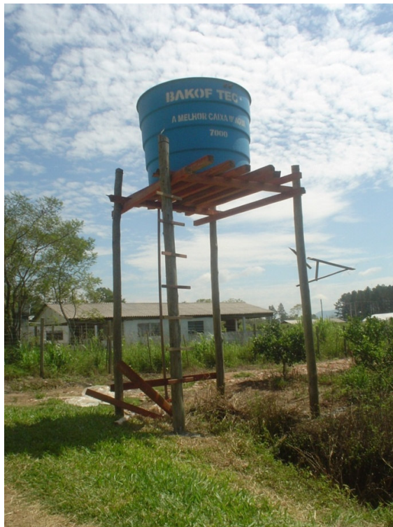
Figura 22 –Reservatório aéreo para acumulação de água (em funcionamento na estação 1, na UFSM – Santa Maria – RS). (Fonte: Foto do autor).
