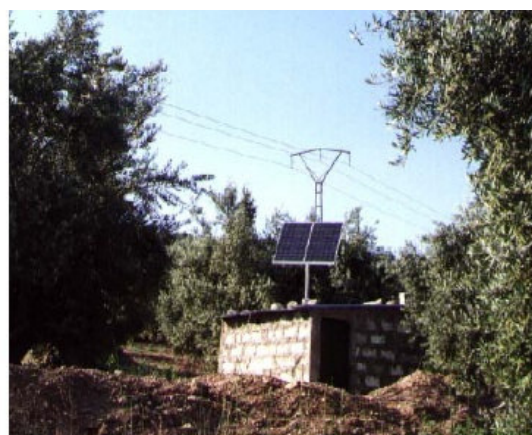
Figuras 11 e 12 – Sistemas de bombeamento fotovoltaico utilizados para irrigação de oliveirais, instalados nas proximidades de uma rede de transmissão de energia elétrica em Jaén, Espanha.
