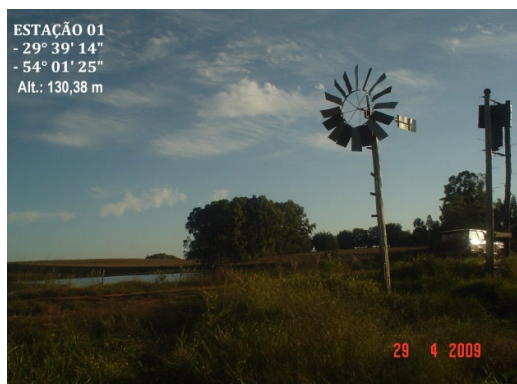
Figura 28 – Estação de bombeamento 1 ( distrito de Canabarro). (Fonte: Foto do autor).
