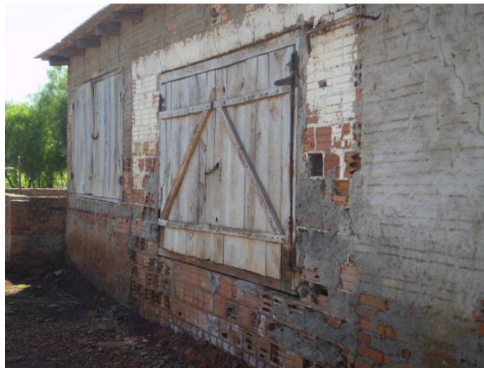
Figura 4.10 – Casa de armazenamento do couro.
