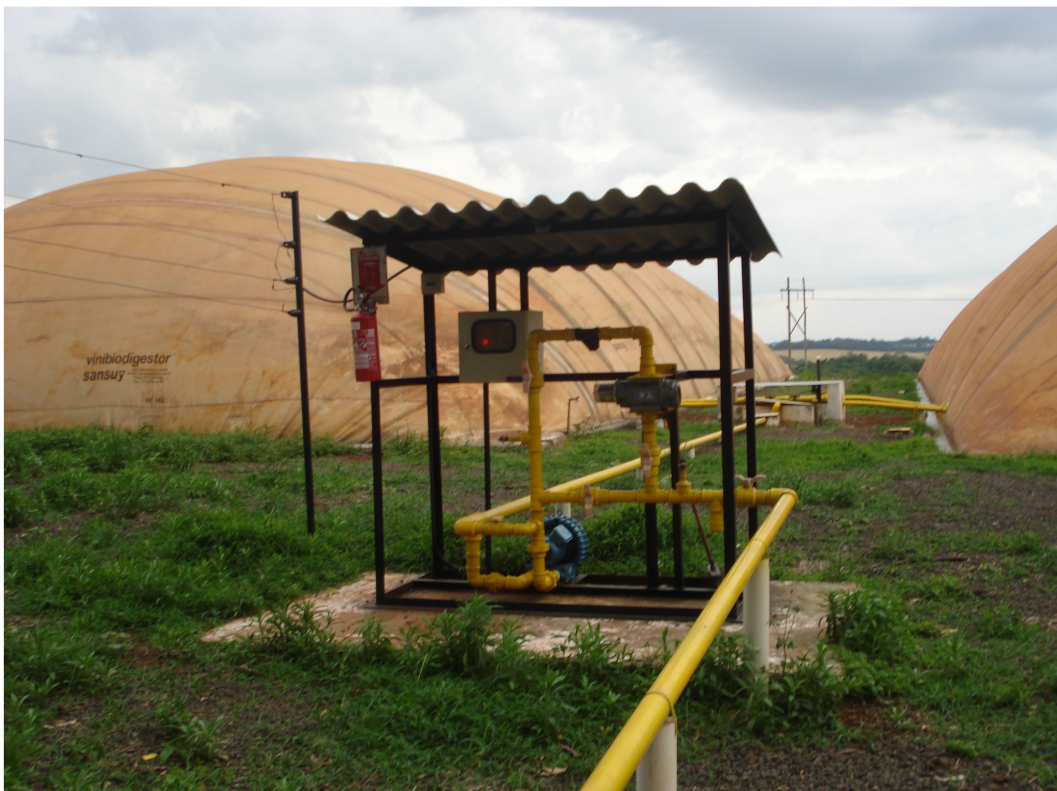
Figura 6 – Equipamentos para medição do biogás - Em primeiro plano.
