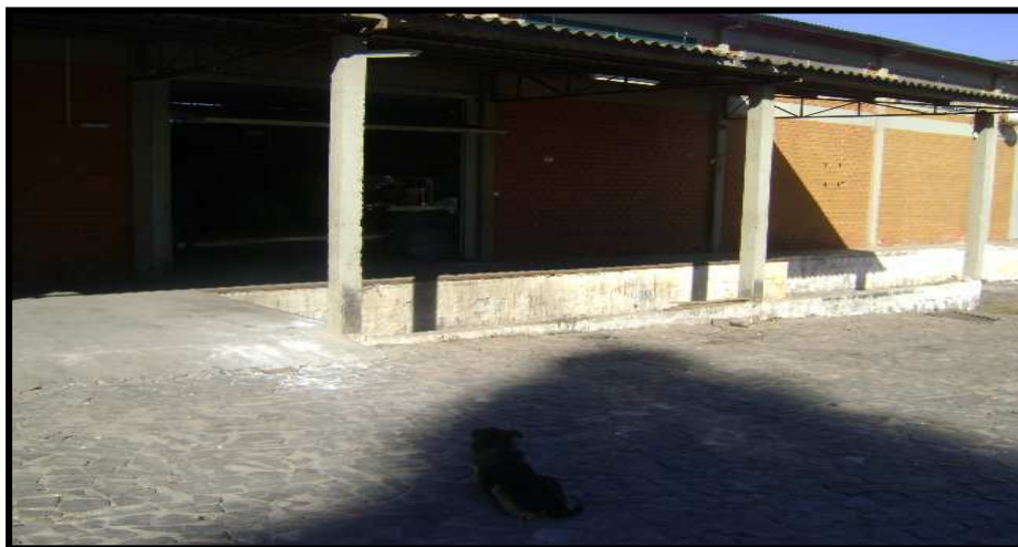
Figura 26 - Área de carregamento de caminhões
