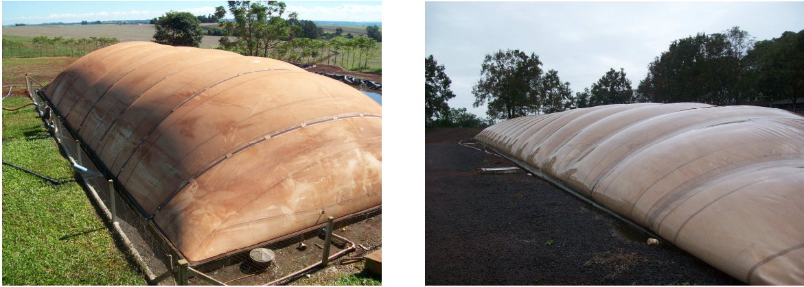
Figura 3 – Modelo canadense de biodigestor Fonte: Arquivo do Autor
