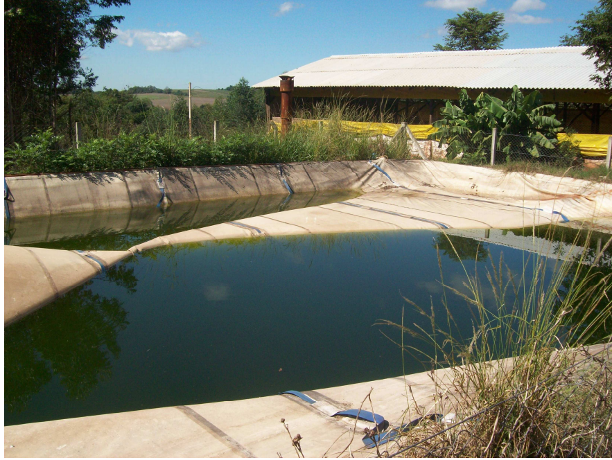
Figura 13 – Biodigestor desativado B Fonte: arquivo do autor
