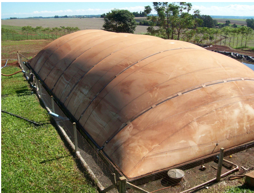
Figura 16 - Biodigestor Fonte: Arquivo do autor
