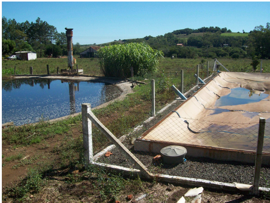
Figura 14 – Biodigestor desativado C Fonte: arquivo do autor
