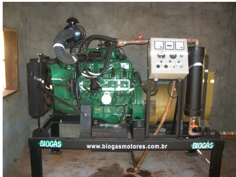
Figura 19 - Conjunto motor-gerador Fonte: Arquivo do Autor
