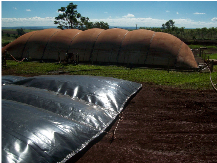
Figura 18 - Biodigestor e balão de armazenamento Fonte: Arquivo do Autor
