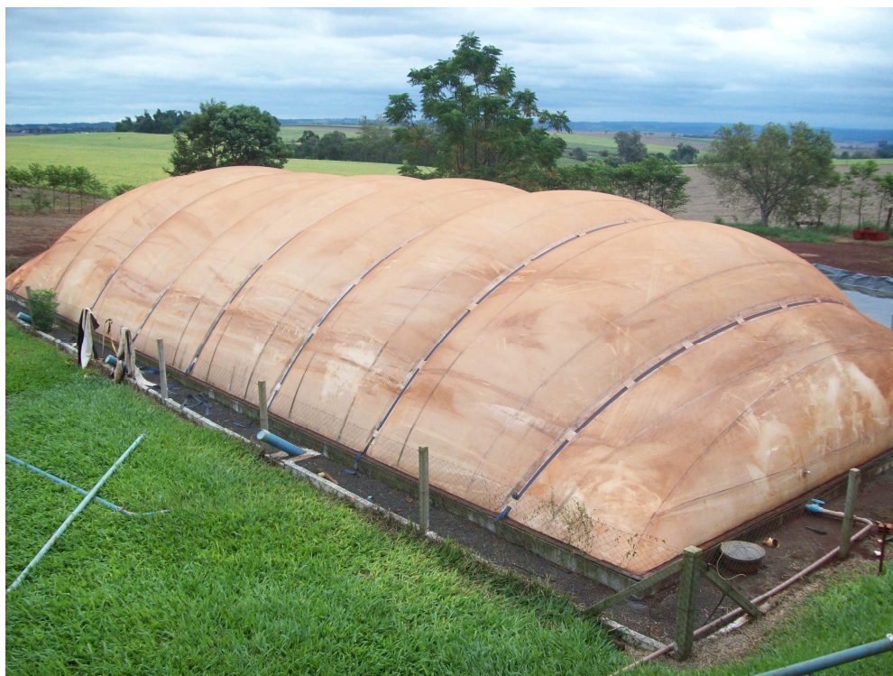
Figura 11- Biodigestor - modelo canadense Fonte: pesquisa
