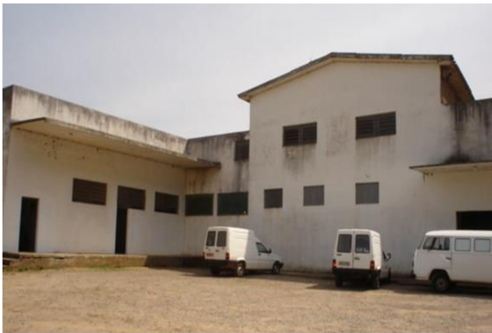
Figura 6 – Fachada da Usina.
