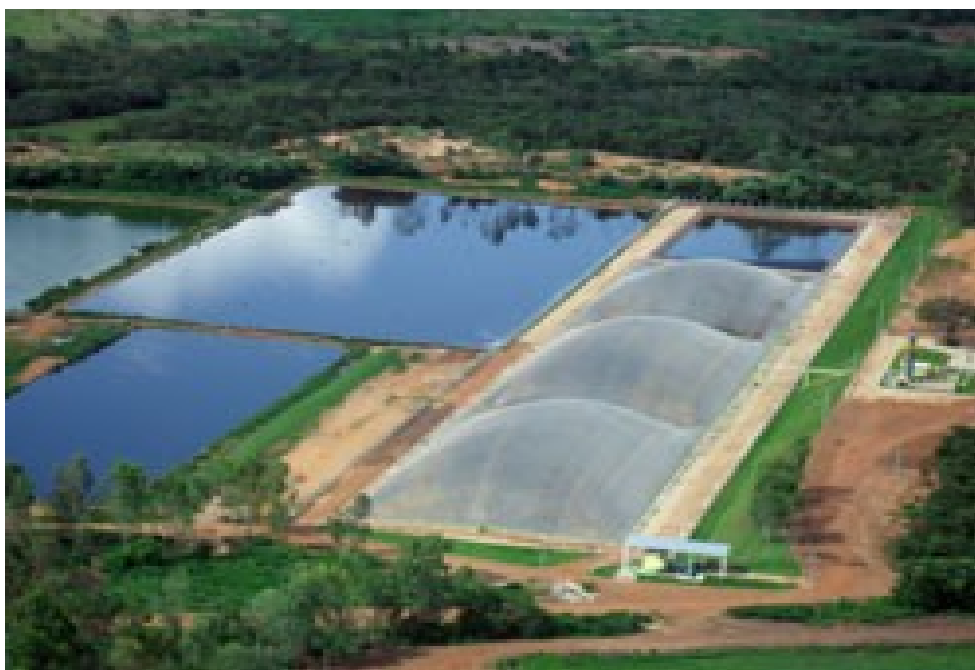
Figura 08 – Biodigestor e lagoas de tratamento de dejetos suínos unidade Seara
