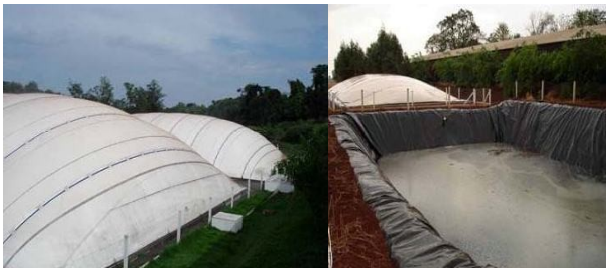
Figura 12 - Biodigestor Canadense seguido de esterqueira Fonte: PEREIRA, DEMARCHI E BUDIÑO (2009)
