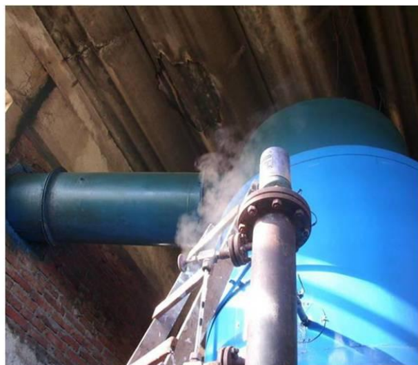
Figura 4 – Perdas de vapor na pasteurização do leite e próximo a caldeira
