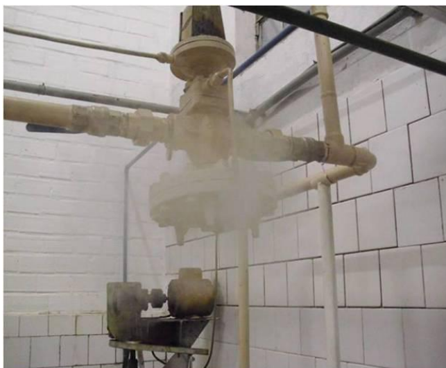
Figura 4 – Perdas de vapor na pasteurização do leite e próximo a caldeira
