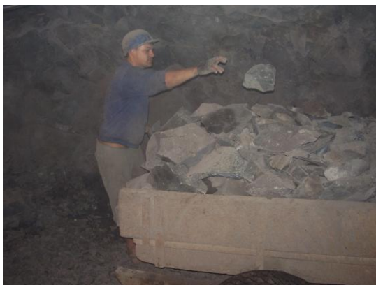
Fonte: Eng.º de Minas Anderson Oliveira da Silva Figura 10: Limpeza da frente de trabalho
