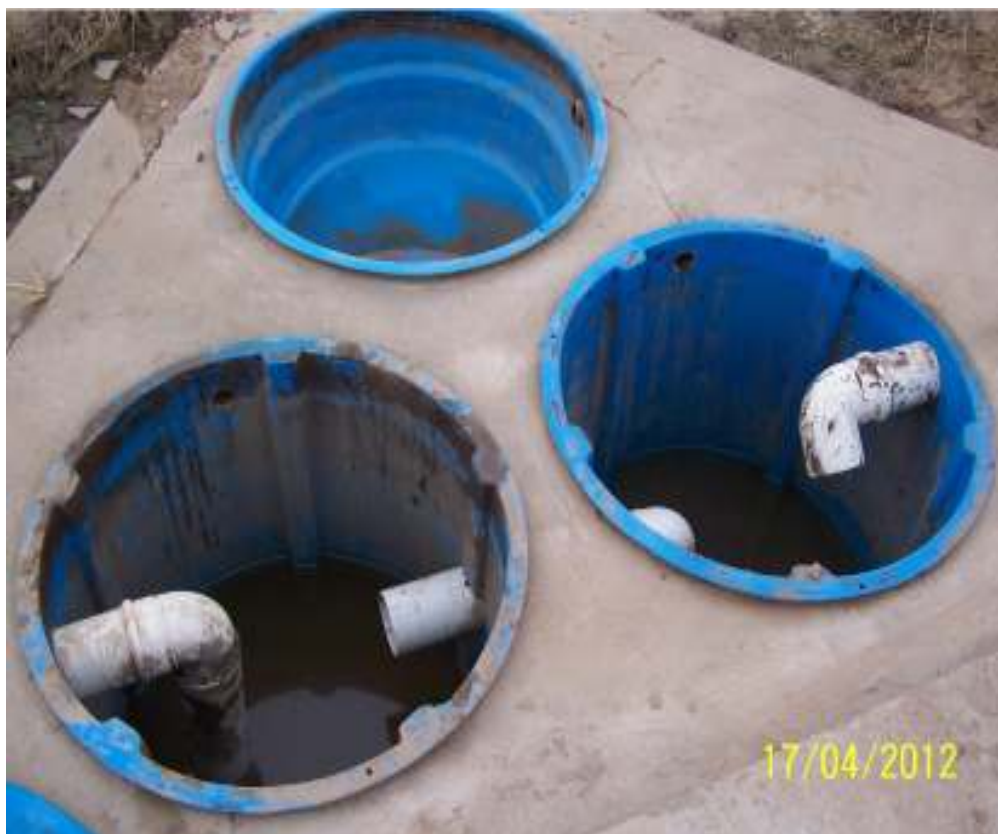
Figura 8 - Sistema de tratamento de efluentes líquidos.
