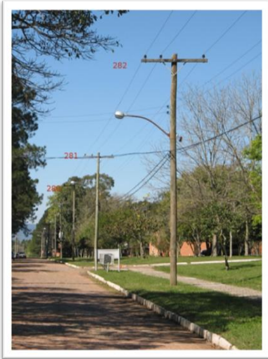
Figura 3.1 - Vista parcial do anel
