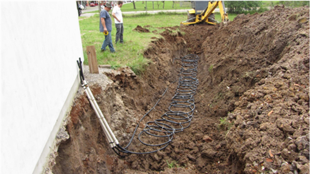
Figura 5.6 – Instalação da mangueira a 1,5 m de profundidade.
