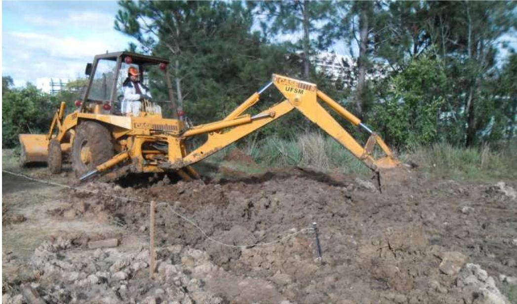
Figura 4.6 - Instalação da sonda multissensora geotérmica (Campus experimental do CEESP - Santa Maria/RS)
