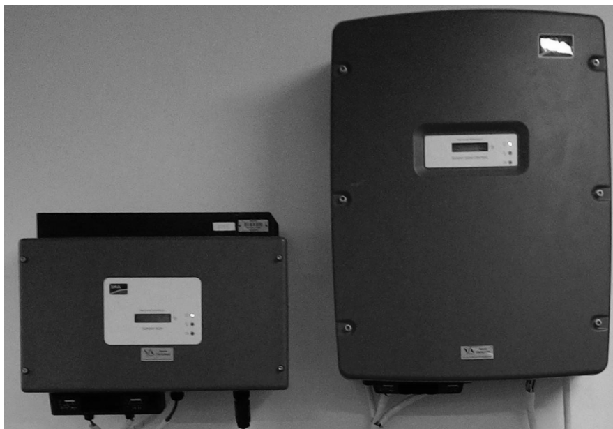
Figura 4.2 – Inversores fotovoltaicos SB2500 (esq.) e SMC6000TL (dir.).
