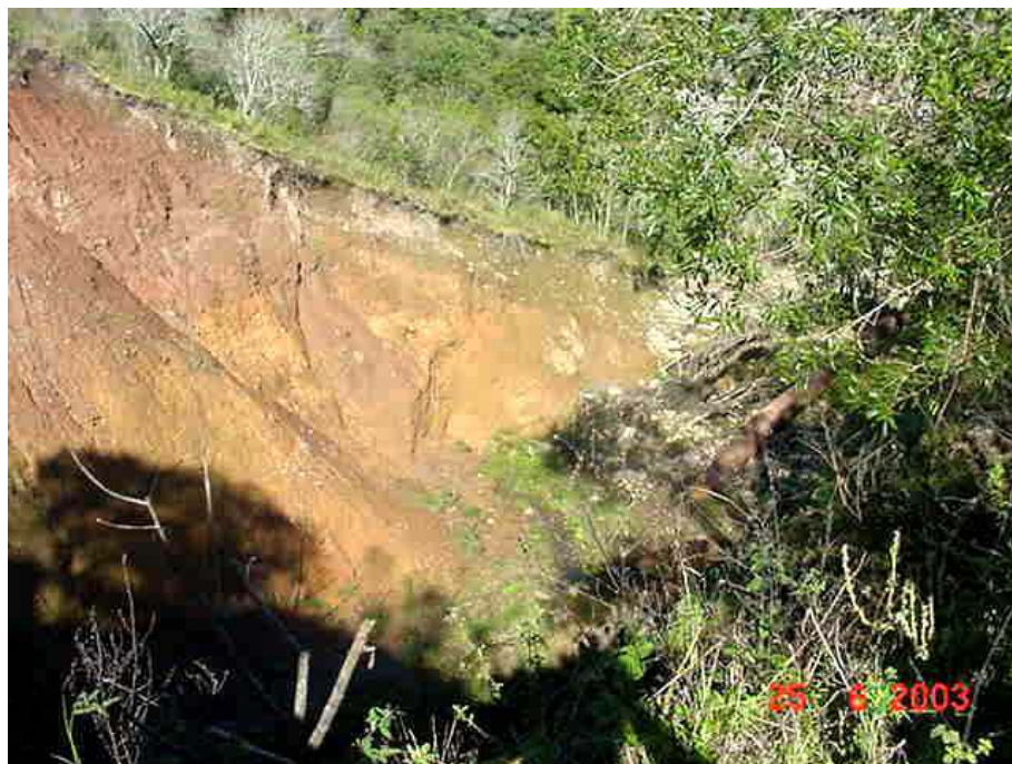
FIGURA 05 – Área deteriorada pelo rompimento de tubulações. (Fotografia cedida pela ELETROBRÁS)
