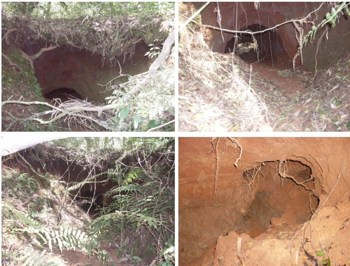
Figura 6 - Pipes localizados na área da Bacia hidrográfica do horto florestal Terra Dura, Eldorado do Sul – RS (Fotos: RODRIGUES, M. F., 15/02/2011).
