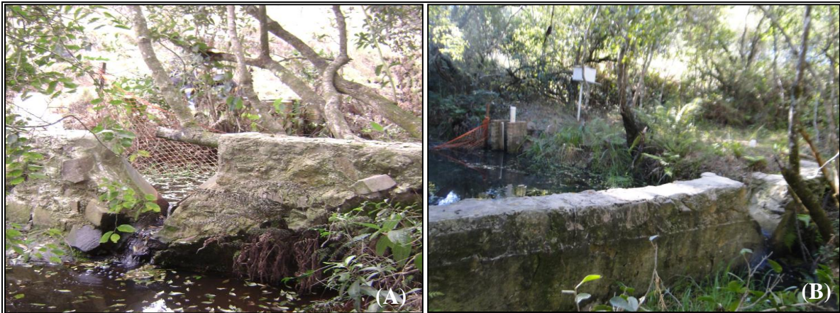
Figura 4.7 – Estrutura hidráulica com poço tranquilizador na MC (A) e ME (B).
