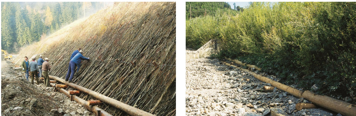
Figura 4.9 – Esteira viva sendo construída (esquerda) e resultado após um ano (direita).
