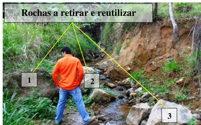
Figura 4.22 – Rochas que devem ser retiradas do leito e reacomodadas na construção do perfil de compensação.
