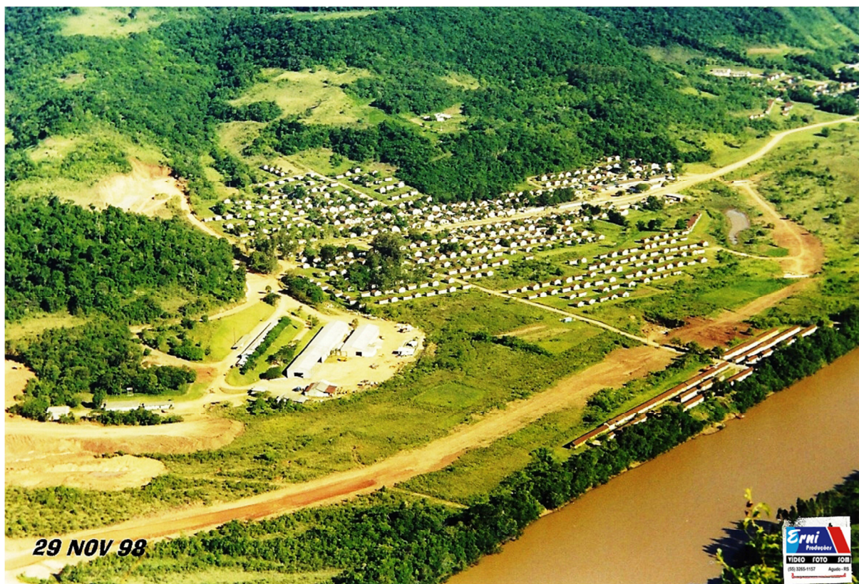
Figura 1. Imagem do ano de 1998, mostrando as benfeitorias e a vila dos funcionários responsáveis pela construção da UHDF. Fonte: Erni fotografias.
