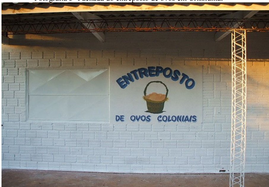
Fotografia 3- Fachada do entreposto de ovos em Crissiumal
