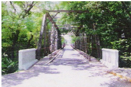
Ponte Rodoviária e da Viação Férrea sobre o Rio Jaguari-RS Fonte: Folder de Jaguari
