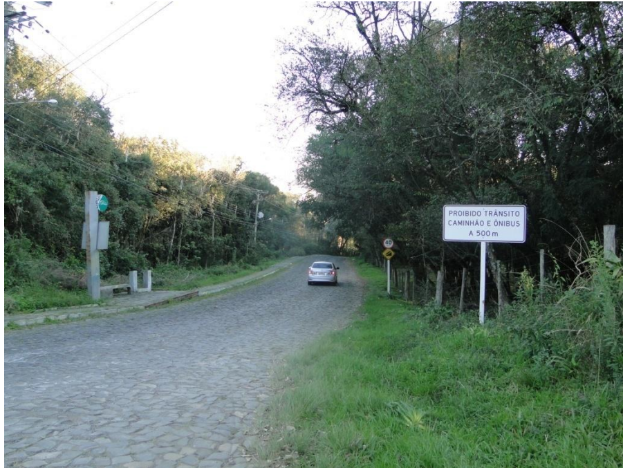
Figura 40 – Sinalização de trânsito após a revitalização, 2013. Fonte: Pesquisa de campo
