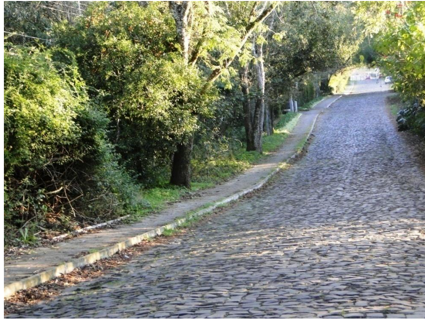
Figura 37 - Estrada do Perau revitalizada, 2013. Fonte: Pesquisa de campo
