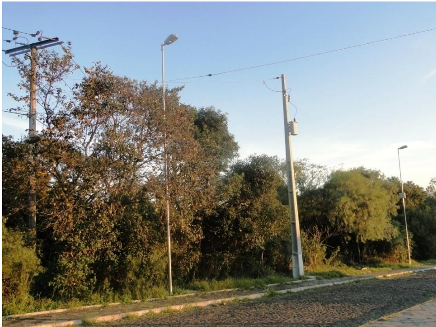
Figura 39 – Postes de iluminação após a revitalização, 2013. Fonte: Pesquisa de campo
