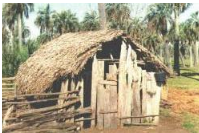
Figura10: Cobertura da casa feita com palha de butiazeiro.. Fonte: Cardoso (1995).
