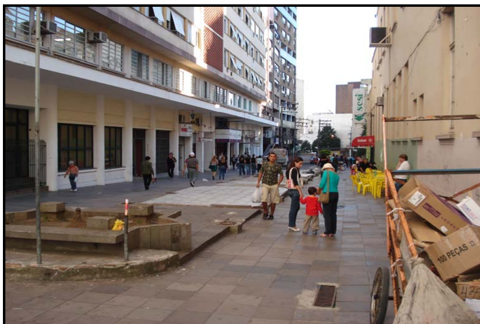
Figura 26 – Fotografia da antiga Rua 24 Horas, no sentido leste/oeste, retratando a falta de limpeza e manutenção.
