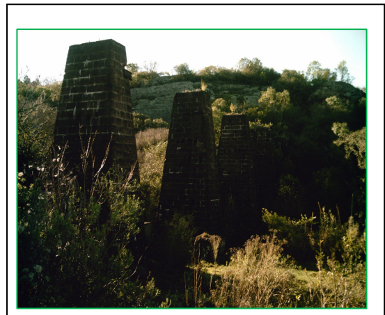
Figura8: Pilares da linha Decauville, para o transporte de vagonetas, século XIX. Fonte: Trabalho de Campo jul. de 2008. Org: SILVA, R.
