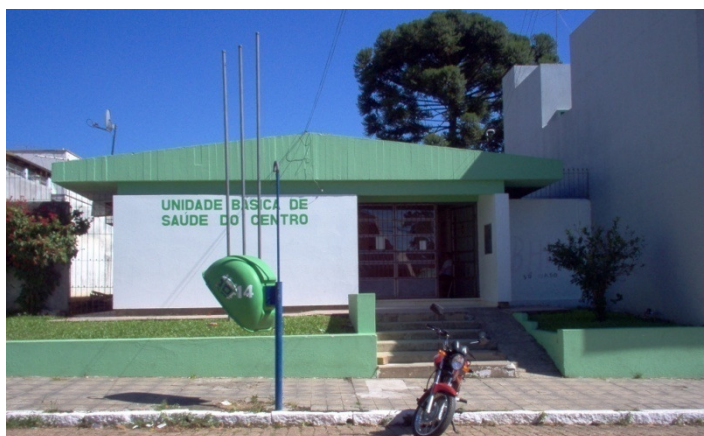
Figura 25 – Posto de Saúde no bairro Centro - São Sepé, RS - 2007.
