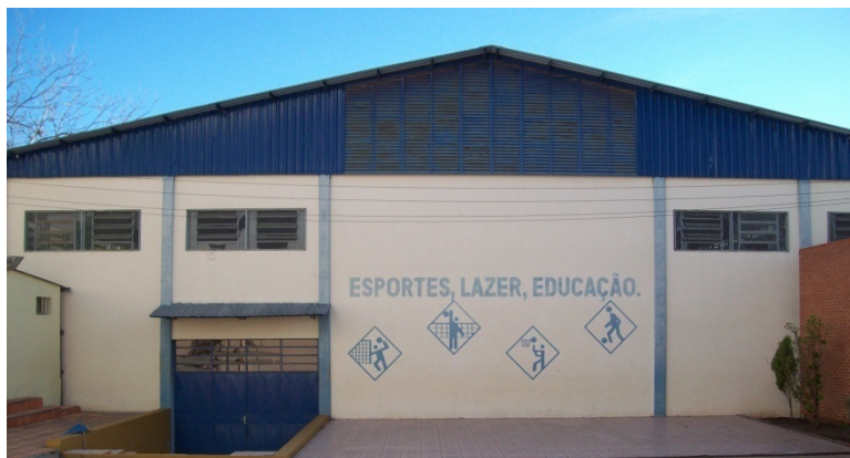
Figura 19 – Quadra de esporte coberta da escola particular - São Sepé, RS – 2008.
