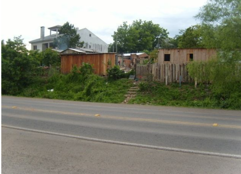
Figura 11- Moradias em situação de alto risco na Ocupação à margem da BR 287, km 252, próximo à ULBRA, vizinha ao bairro Parque Pinheiro Machado em Santa Maria-RS
