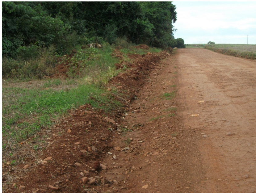
Figura 13: Estrada municipal observa-se pequenos taludes nas laterais. Fonte: Bertoldo, maio/2010.
