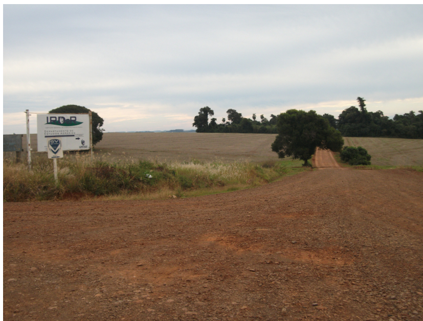
Figura 12: Vista parcial da estrada que foi realizado rebaixamento dos taludes e de acesso ao antigo CTC, atual IRDeR.
