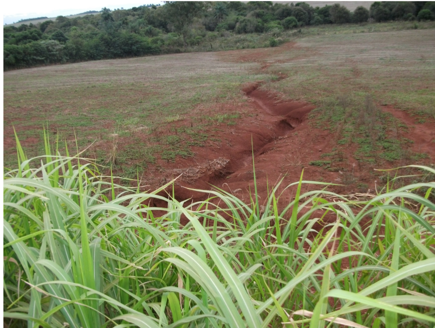
Figura 14: Área com processo erosivo. Fonte: Bertoldo, maio/2010.
