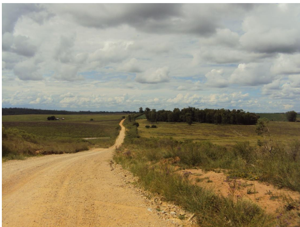
Fotografia 10 - Estradas locais no distrito do Vacacaí Localização - Lat. 6611635.38 m S, Long. 747368.83 m E, Fuso 21, (Pto.rur.6)
