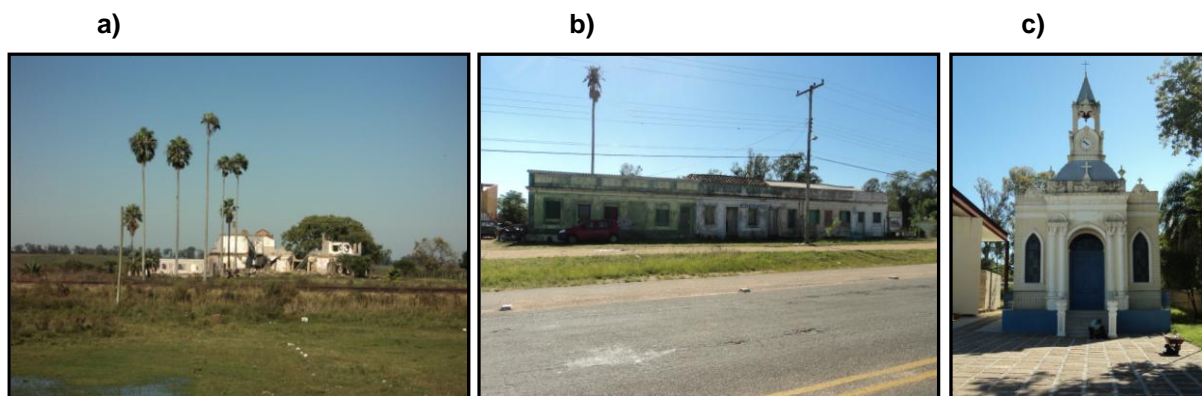
Figura 21 – Vila Santa Thereza em Bagé: a) Ruínas do palacete de verão da família do Visconde de Magalhães; b) Antigas casas dos operários da vila, localizadas na Av. Visconde de Ribeiro Magalhães e c) Capela de Santa Thereza, restaurada.
