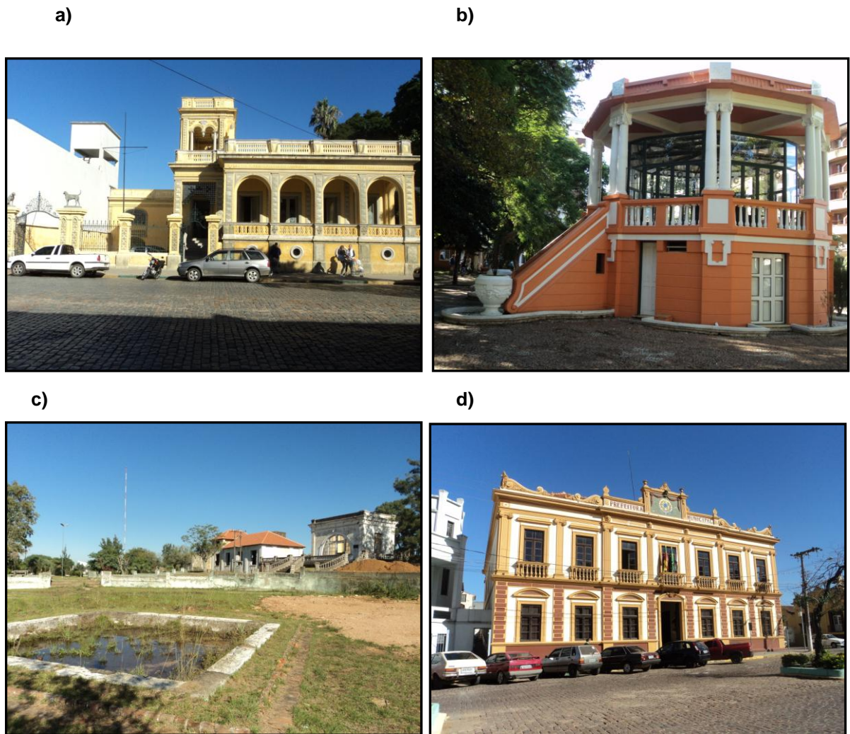
Figura 20 – Exemplos de prédios históricos em Bagé: a) Palacete Pedro Osório; b) Coreto Municipal; c) Hidráulica de Bagé e d) Prefeitura Municipal. Fonte – Trabalho de campo, abril de 2011.
