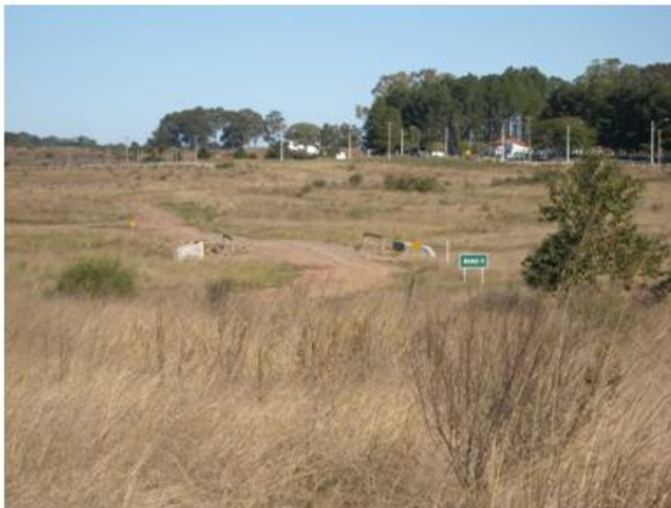
Figura 45 - Ponte construída próximo ao CIBLD.
