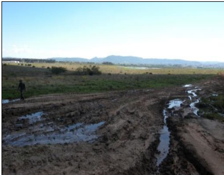
Figura 51 - Atoleiros ou “Borrachudos” devido à baixa capacidade de carga do solo.
