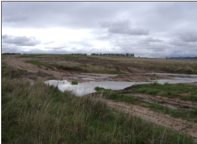
Figura 44 - Erosão de margem causada por passagem de blindados.
