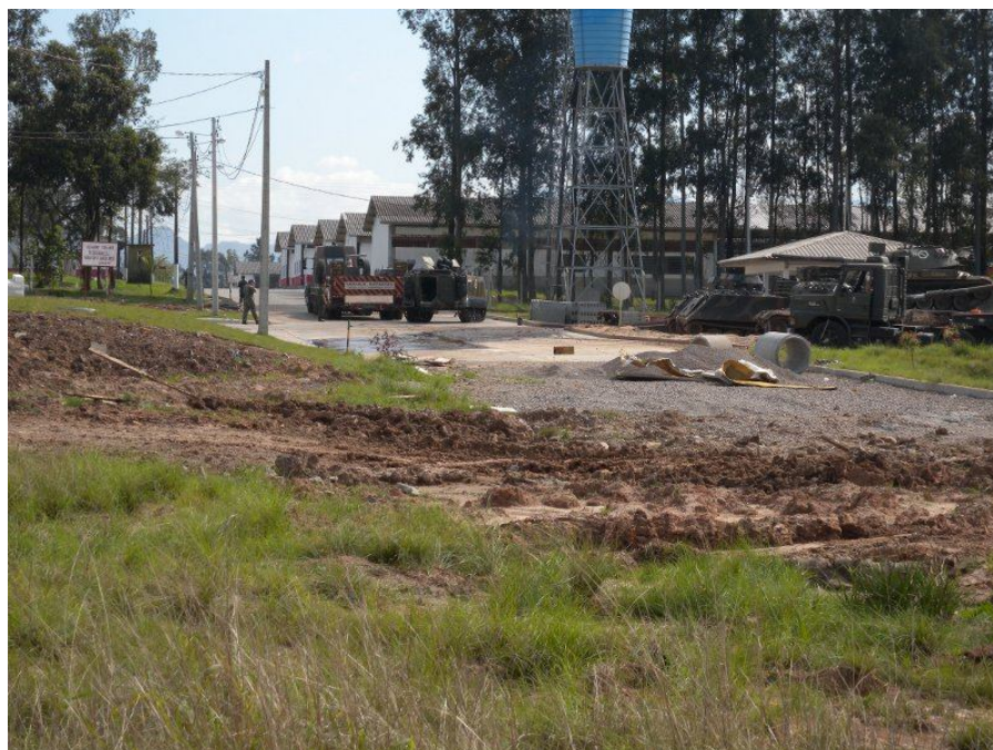
Figura 39 - Rampa de acesso ao CISM, pelo CIBLD já com a área de dissipação.
