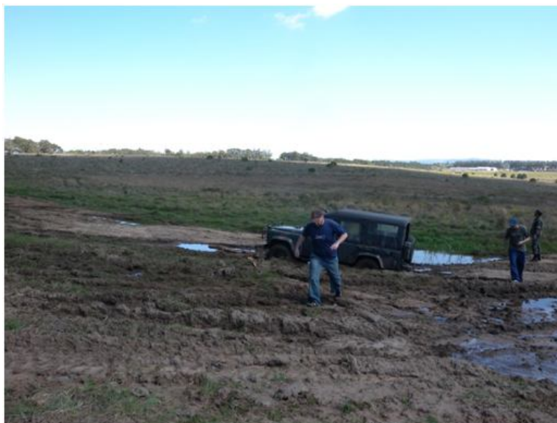
Figura 52 - Atoleiros ou “Borrachudos” devido à baixa capacidade de carga do solo.
