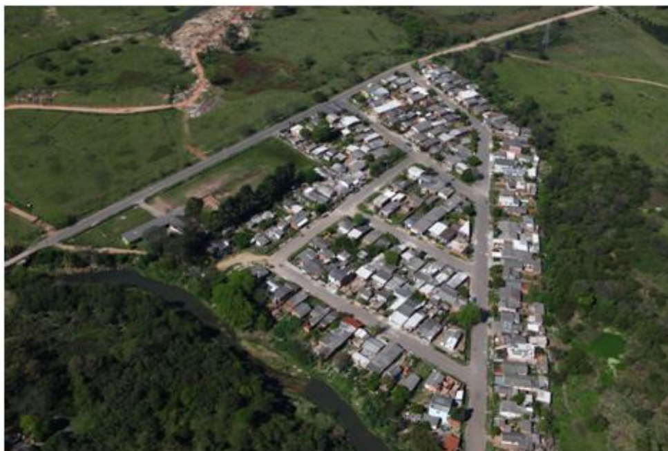
Figura 36 - Pontos de assoreamento e escorregamento de margem a jusante da área no CISM, no arroio Cadena. Foto cedida pelo Exército.
