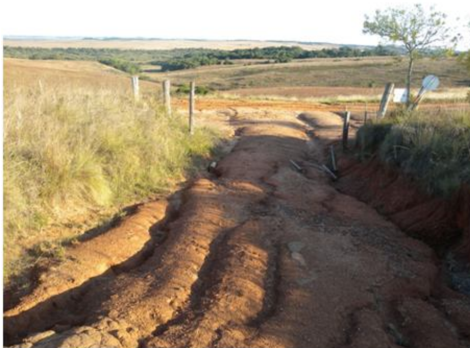
Figura 50 - Sulcos e ravinas desenvolvidos em estrada cujo material do leito está compactado.
