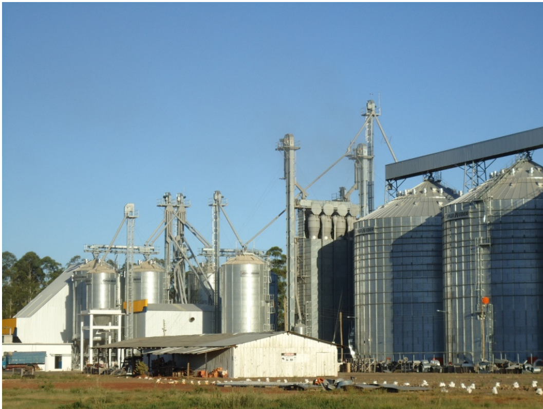
Fotografia 24 – Estrutura de recebimento, limpeza, secagem e armazenagem de arroz.
