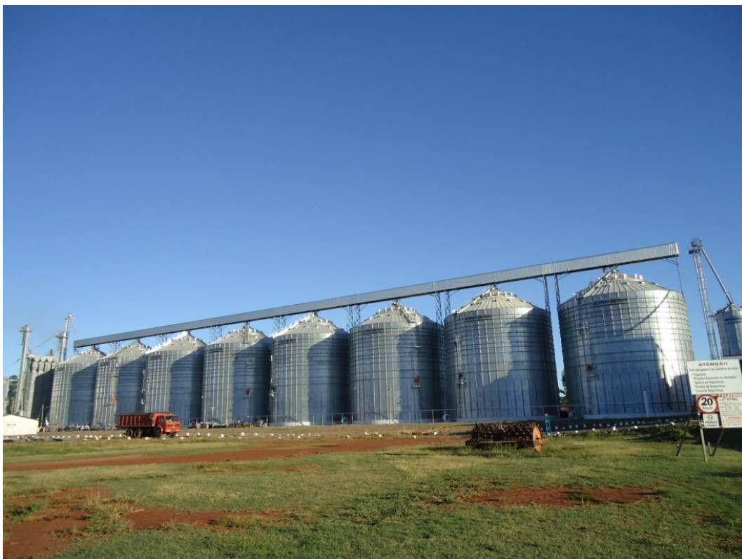
Fotografia 23 – Estrutura de armazenagem de arroz, silos, situada no espaço urbano.
