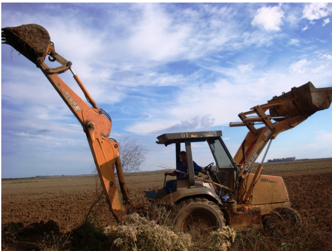
Fotografia 20 – Retroescavadeira em funcionamento fazendo um valo para a condução de água.
