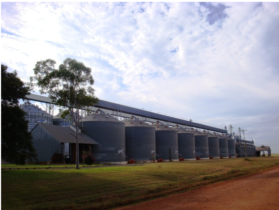
Fotografia 22 – Estrutura de secagem e armazenagem de arroz situada no espaço rural.
