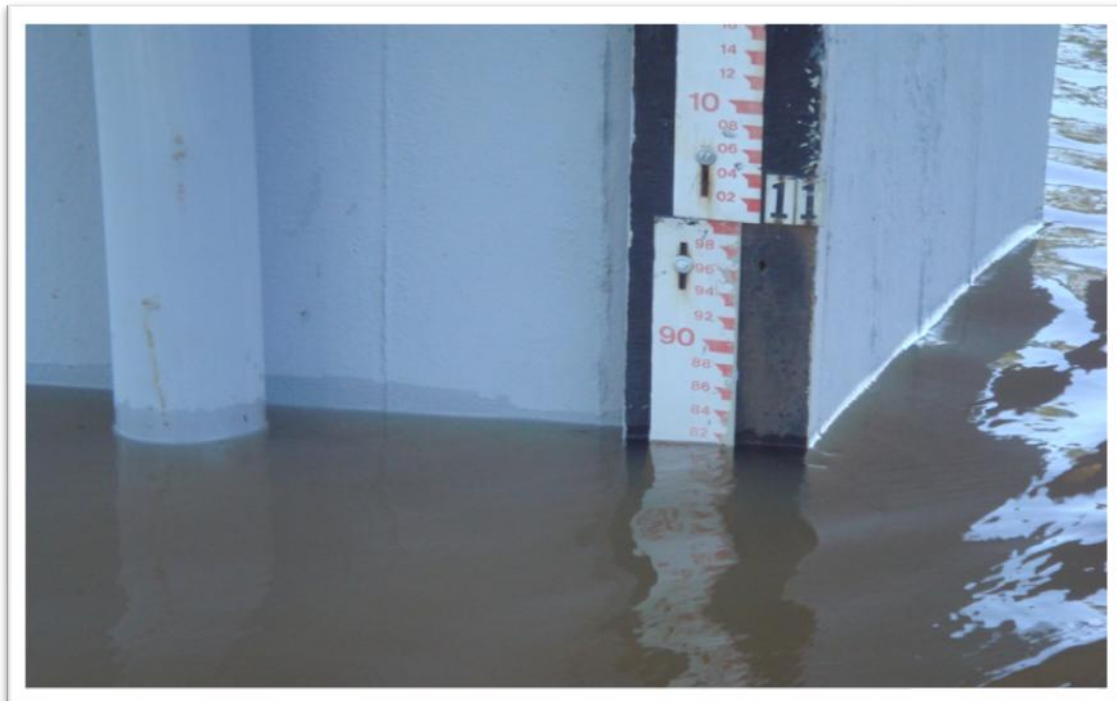
Figura 20: Foto da régua linimétrica no Porto de Itaquí. Inundação de novembro de 2008 atingindo cota fluviométrica de 10,81m. Fonte: MEYER, C., 2008.
