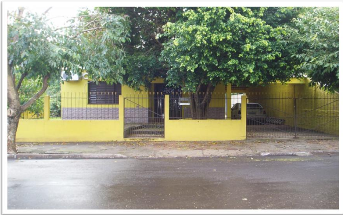
Figura 29: Rua Bento Gonçalves, Itaqui. Casa com baixo grau de vulnerabilidade. Fonte: Trabalho de campo, 2011.
