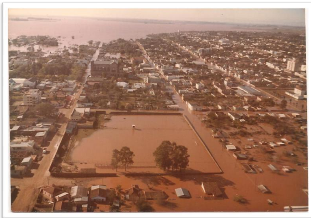
Figura 24: Foto da quadra do Presídio de Itaqui, inundaç o extraordin ria de 1983. Cota fluviom trica de, aproximadamente, de 14,52m. Fonte: FLORES, A. E., FLORES, A. M., 1983.
