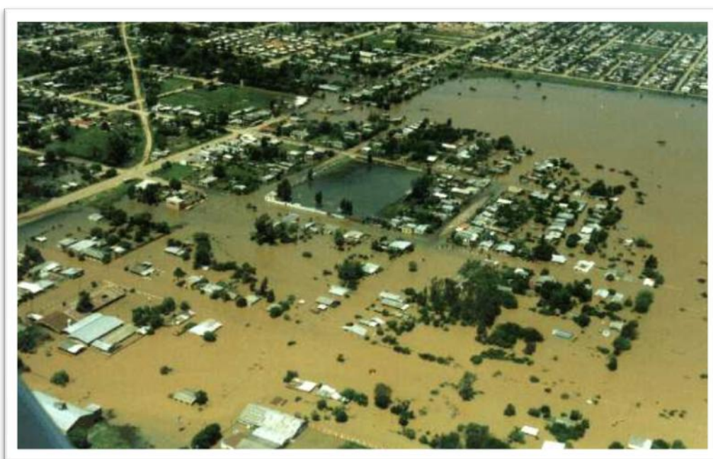
Figura 25: Foto do Bairro Vinte e Quatro de Maio, inundaç o extraordin ria de 1983. Cota fluviom trica de, aproximadamente, de 14,52m. Fonte: BOEIRA, J. 1983.
