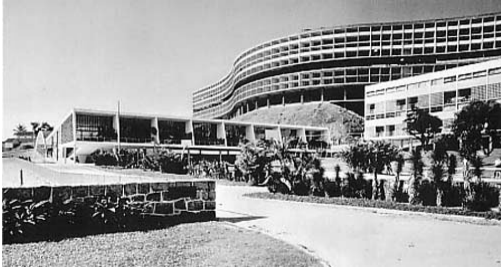
Figura 2.2.1: Conjunto Pedregulho – Rio de Janeiro
