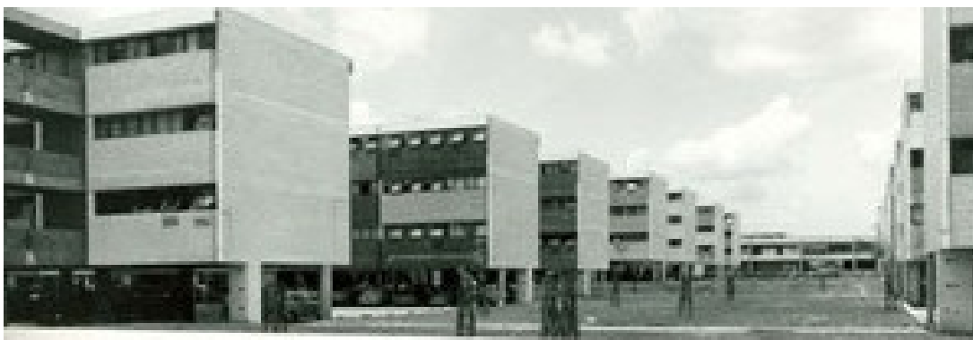
Figura 2.5.1: Conjunto Habitacional Zezinho Magalhães – Guarulhos, SP Fonte: http://www.vitruvius.com.br/revistas/read/arquitextos/08.088/207
