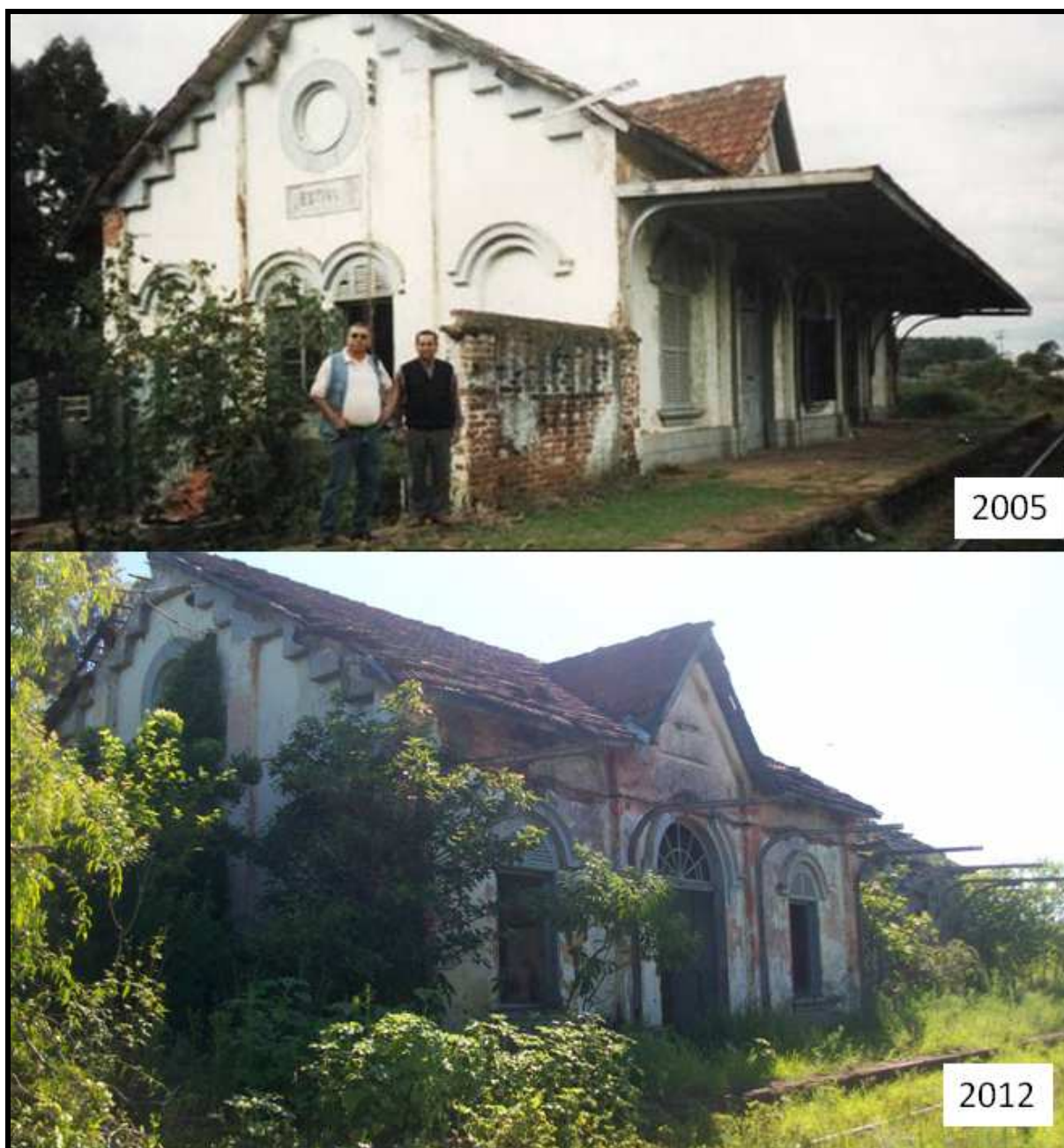
Figura 22: A fotografia superior retrata a antiga estação de Estiva em 2005, ainda em estado regular de preservação. Na fotografia do inferior, a antiga estação da Estiva, em janeiro de 2012, abandonada e depredada.
