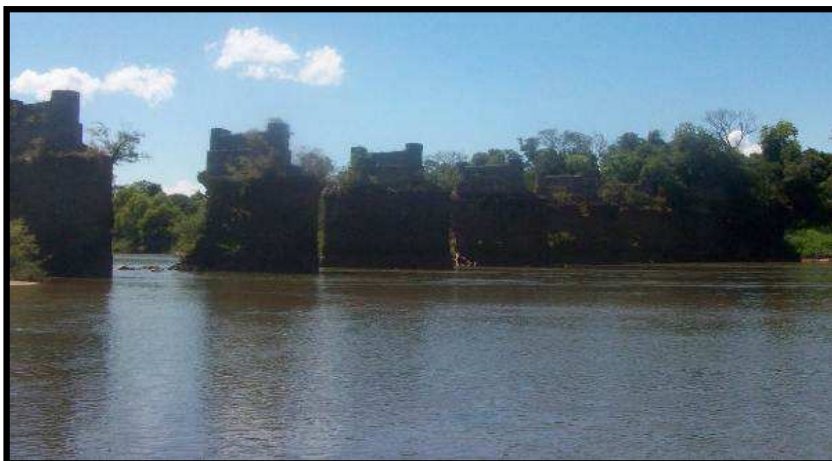
Figura 08: Fotografia das ruínas da Antiga Ponte do Império, sobre o Rio Jacuí, utilizada para o transporte, especialmente, de charque para o interior do estado do Rio Grande do Sul (na época, Província), de 1871 a 1894.
