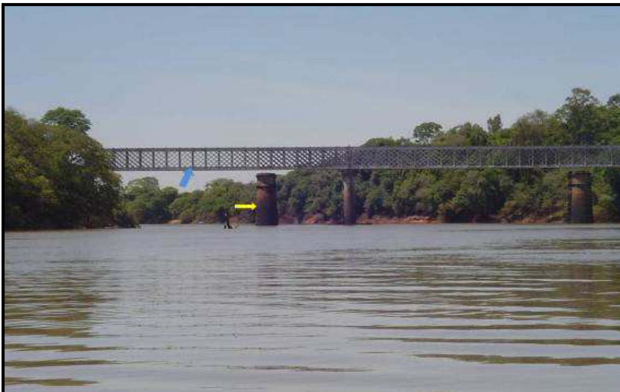
Figura 14: Fotografia da ponte ferroviária sobre o Rio Jacuí, na linha Férrea Porto Alegre- Uruguaiana, trecho entre Cachoeira do Sul e Restinga Sêca/RS. Em destaque (indicação amarela) ruínas de seu antigo alicerce construído entre 1880 e 1885. A ponte passou por uma reconstrução e revestimento de aço (indicação azul), sendo utilizada até hoje pela empresa de transporte de cargas ferroviárias ALLMS. Fotografia sem data definida.
