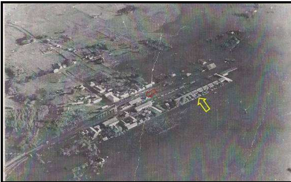
Figura 11: Fotografia da enchente do ano de 1941, no povoado de Jacuí, registra a configuração urbana, existente na época, em destaque a estação Jacuí (indicação vermelha) e o depósito de locomotivas das Oficinas Ferroviárias (indicação amarela).
