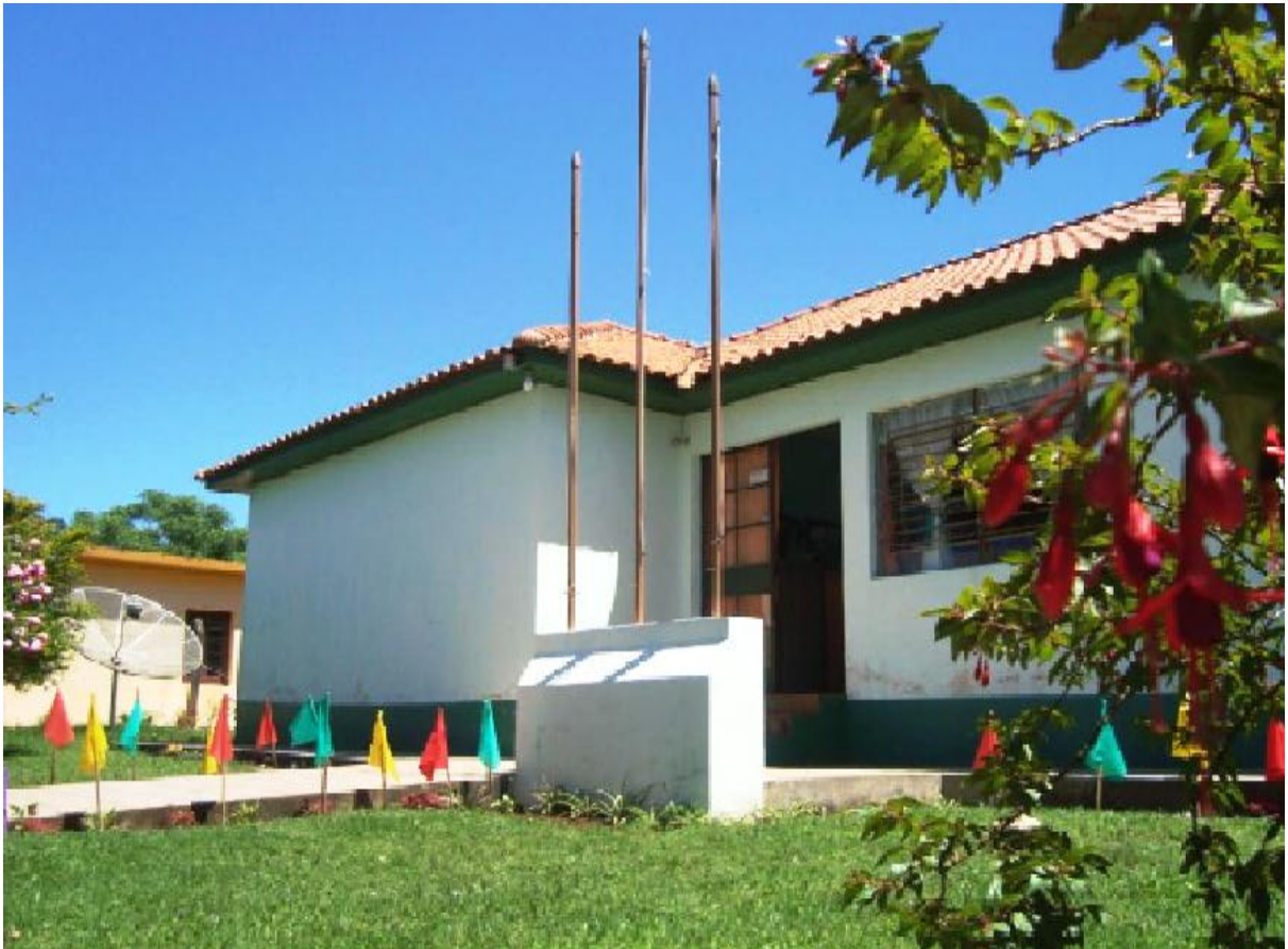
Figura 04 – Vista Frontal da E.E.E.F. Joaquim José da Silva Xavier Fonte: Acervo da autora
