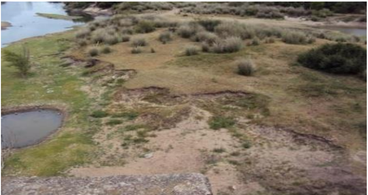
Foto 3 – Margem do rio Santa Maria, em trecho urbano. A erosão das margens foi provocada pela extração de areia irregular. Fonte: Dom Pedrito, 2011.
