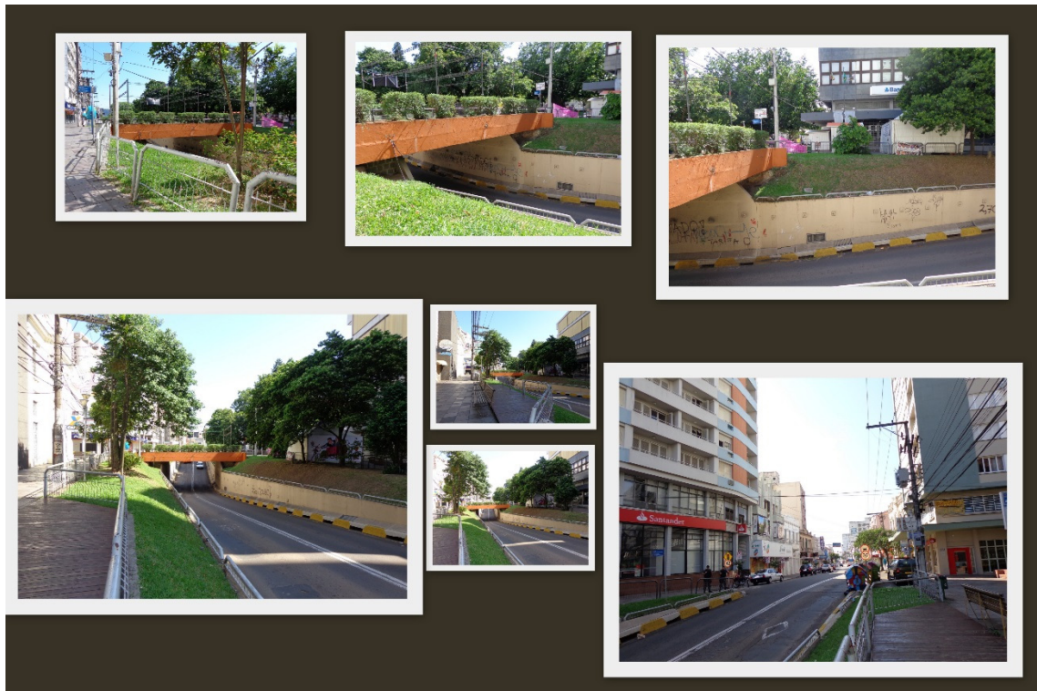
Figura 14 – Rua do Acampamento. Em destaque alguns detalhes do início da Rua do Acampamento e do Viaduto Evandro Behr. Fonte: Neida M. C. Freitas/2013.
