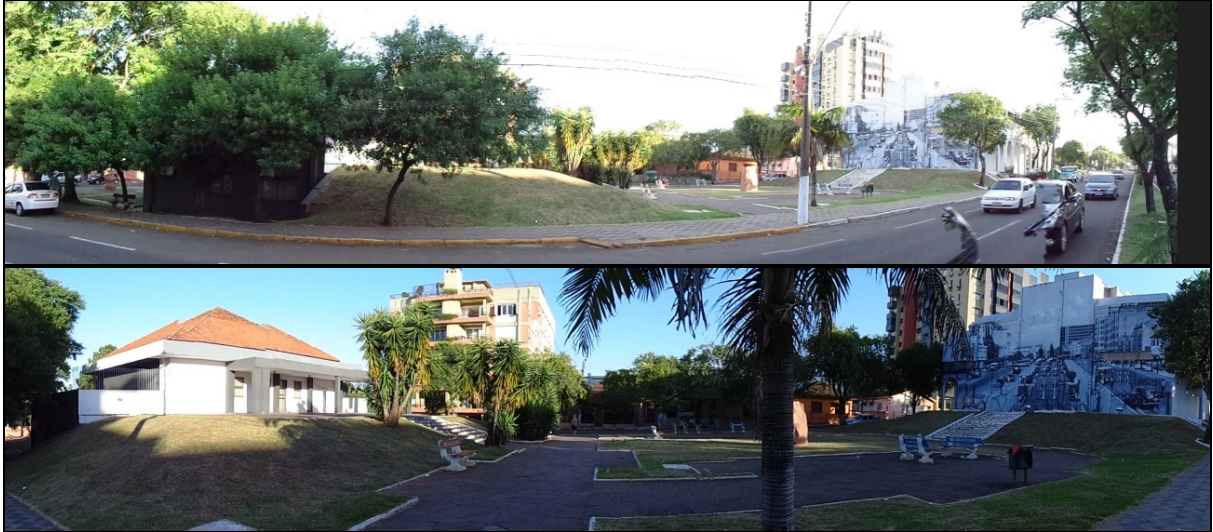
Figura 05 – Vista panorâmica do Centro Integrado de Cultura. No primeiro plano à esquerda, o AHSM. No segundo plano à esquerda, a Sala de Exposições. Fonte: Neida M. C. Freitas/2013.
