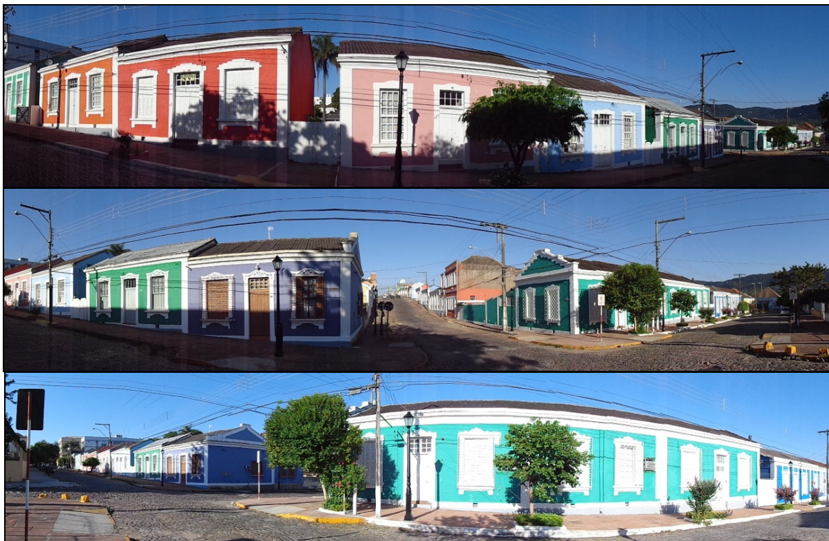
Figura 21 – Vista panorâmica da Vila Belga. Quarteirão 3 e 4: Em primeiro plano a Rua André Marques. Em segundo plano, o entroncamento das ruas André Marques e Ernesto Becker. No terceiro plano, o entroncamento das ruas André Marques e Ernesto Becker (ao fundo); e ruas André Marques e Manoel Ribas (frente).
