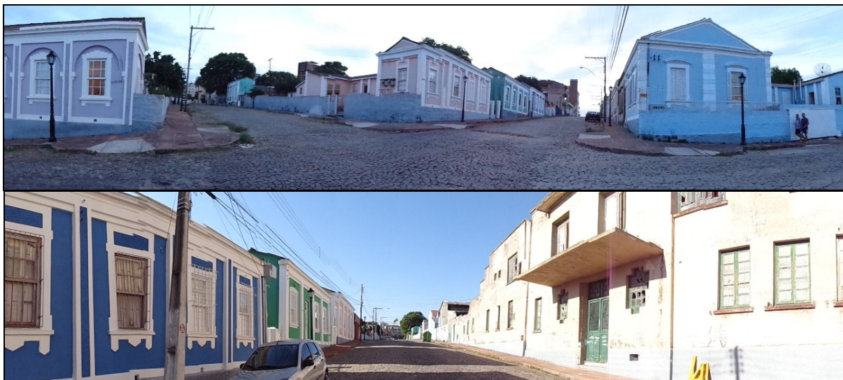
Figura 19 – Vista panorâmica da Vila Belga. Quarteirão 1 e 3: Rua Ernesto Becker. No primeiro plano, entroncamento das ruas Ernesto Becker e Dr. Wautier. No segundo plano, a Rua Dr. Wautier, no sentido bairro-centro.
