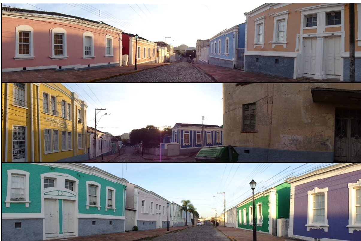
Figura 20 – Vista panorâmica da Vila Belga. Quarteirão 2 e 4: Rua Manoel Ribas. No primeiro e segundo plano, no sentido centro-bairro. No terceiro plano, no sentido bairro-centro.
